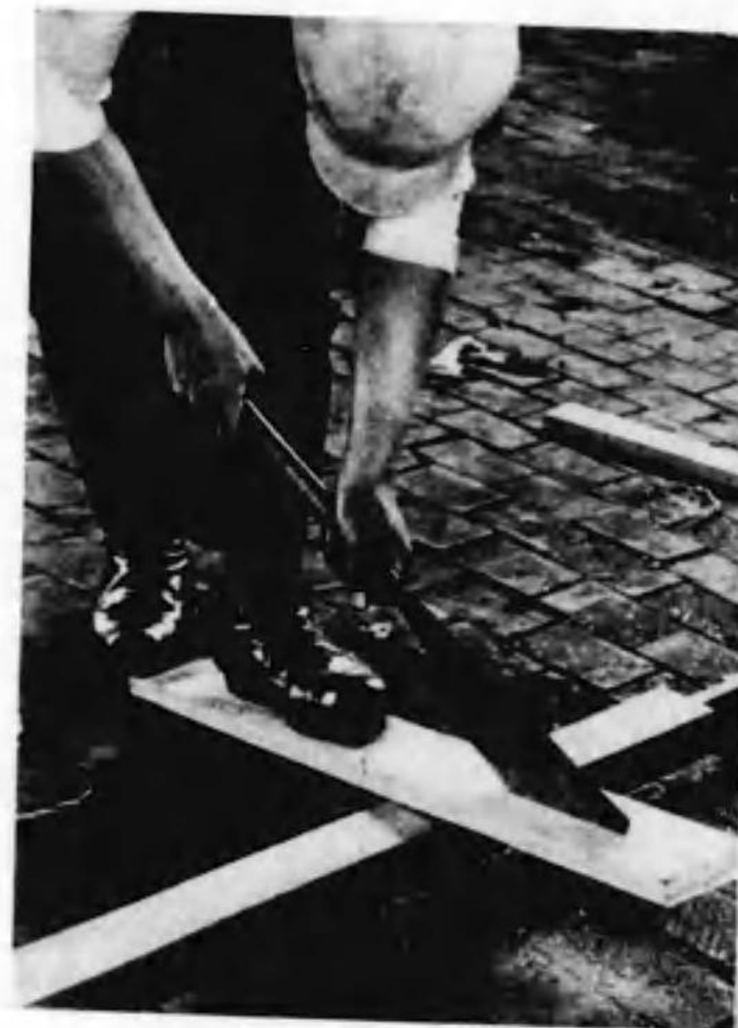
縦挽鋸の使ひ方
