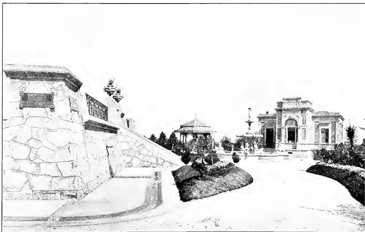
RESERVOIR DA LIBERDADE, SÃO PAULO.
