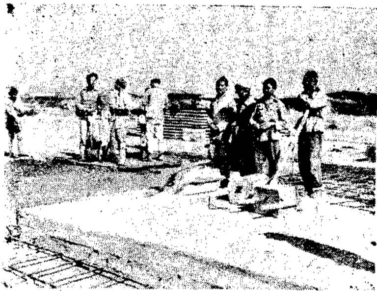
混凝土的拌合，是按照 1:2:3 的標準比例，即水泥一份，黃砂二份，碎石三份，這是拌合前過量情形。
