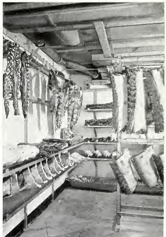
KÜHLRÄUME FÜR KALTE KÜCHE UND FLEISCH.
