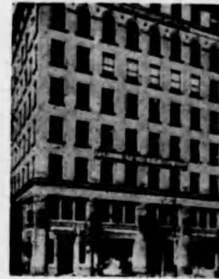
Meidiya Bldg., Tokyo
