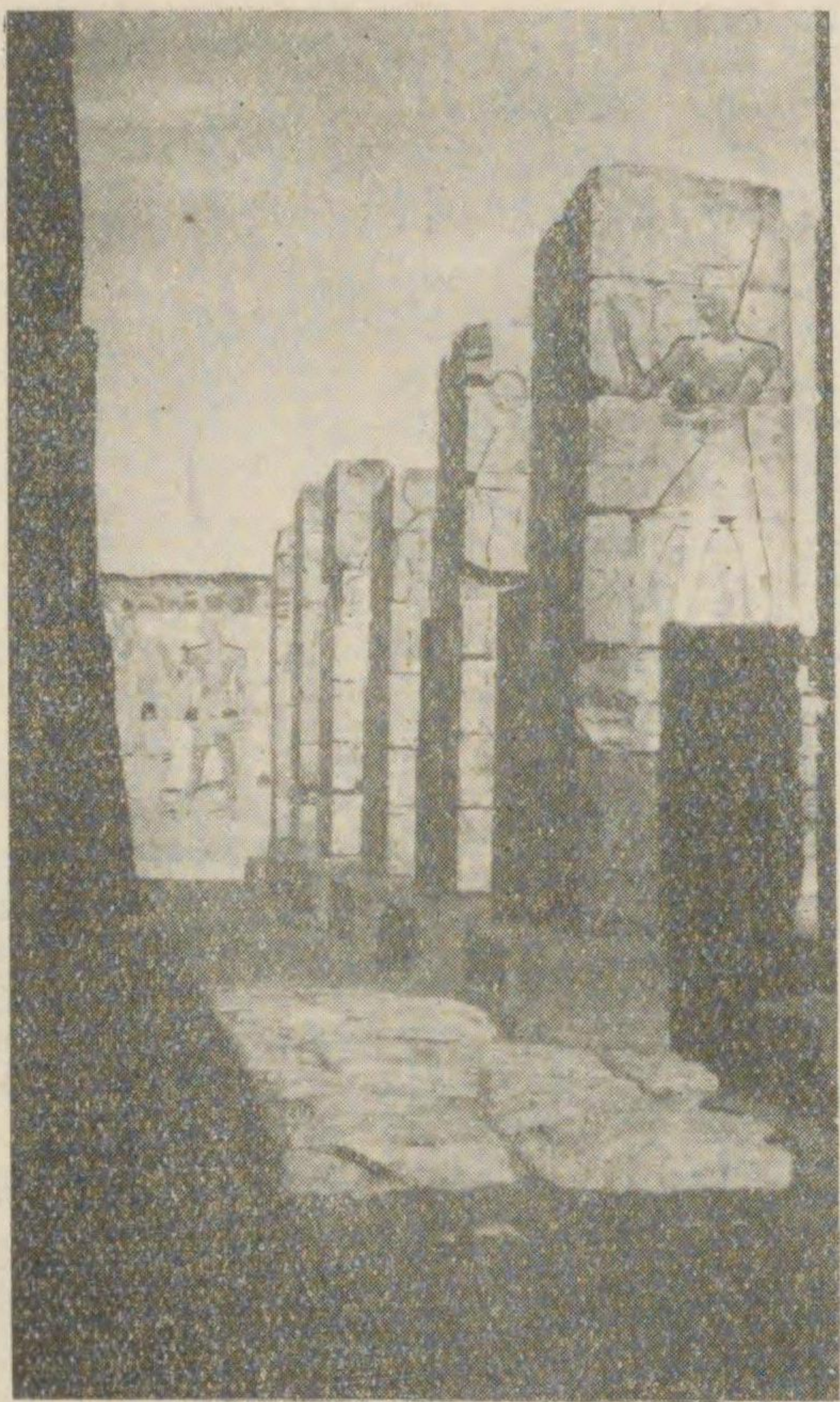
セトス一世堂第二中庭 正面の列柱一部
