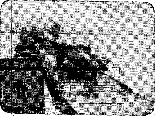
越南北方广平省人民军某部指战员，为了尽快医治战争创伤，帮助恢复交通建设，在河内宽广、水流湍急的黄河下游，仅用十天就架起了一座长达五百二十二米的浮桥。
