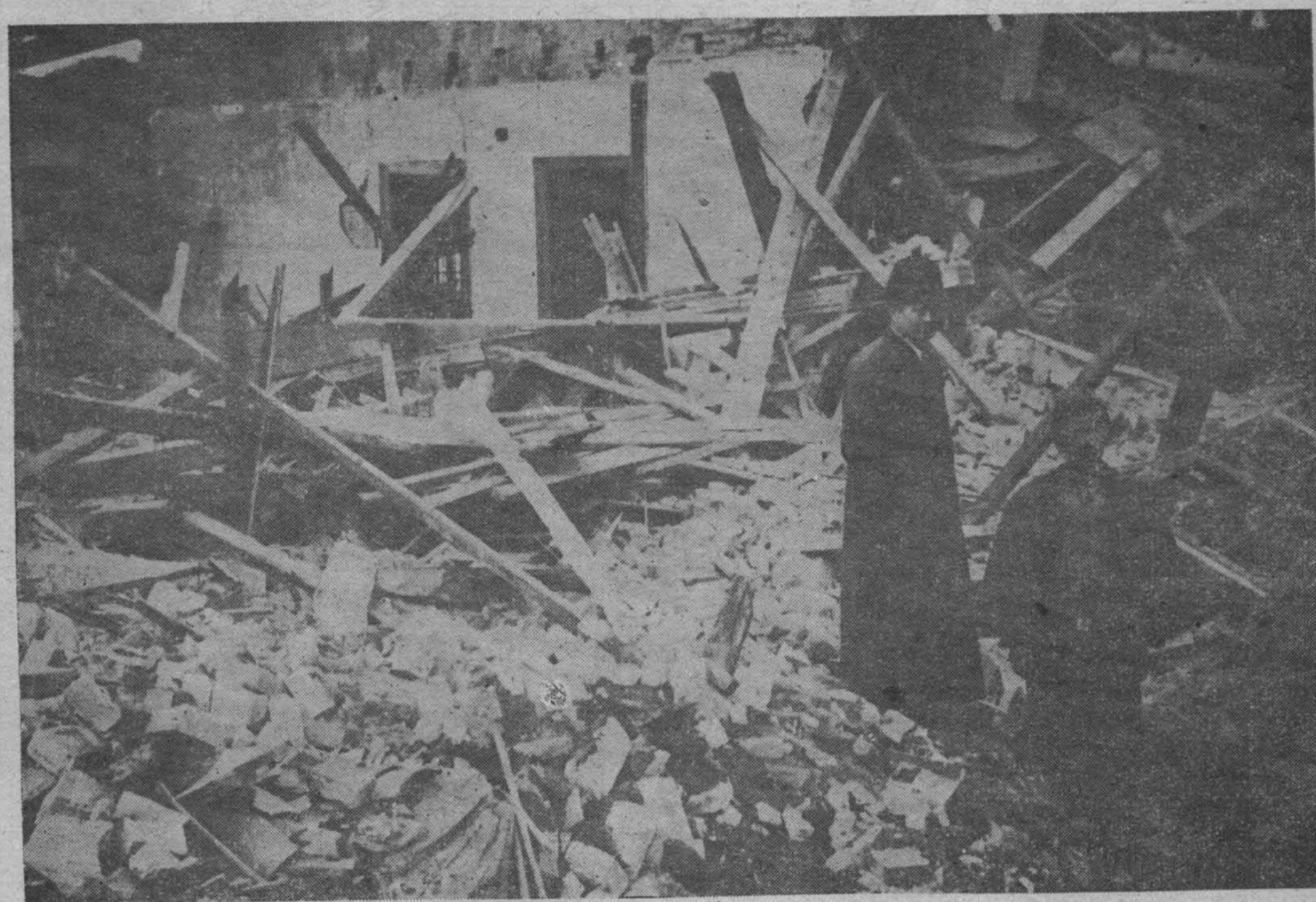
房 屋 被 炸 彈 炸 毀 的 情 形
