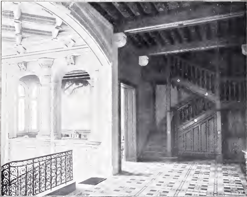
Escalier, Antichambre au premier étage.
