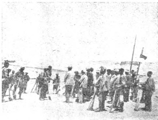
林水開渠第一日本會工程師召集工人訓話情形
