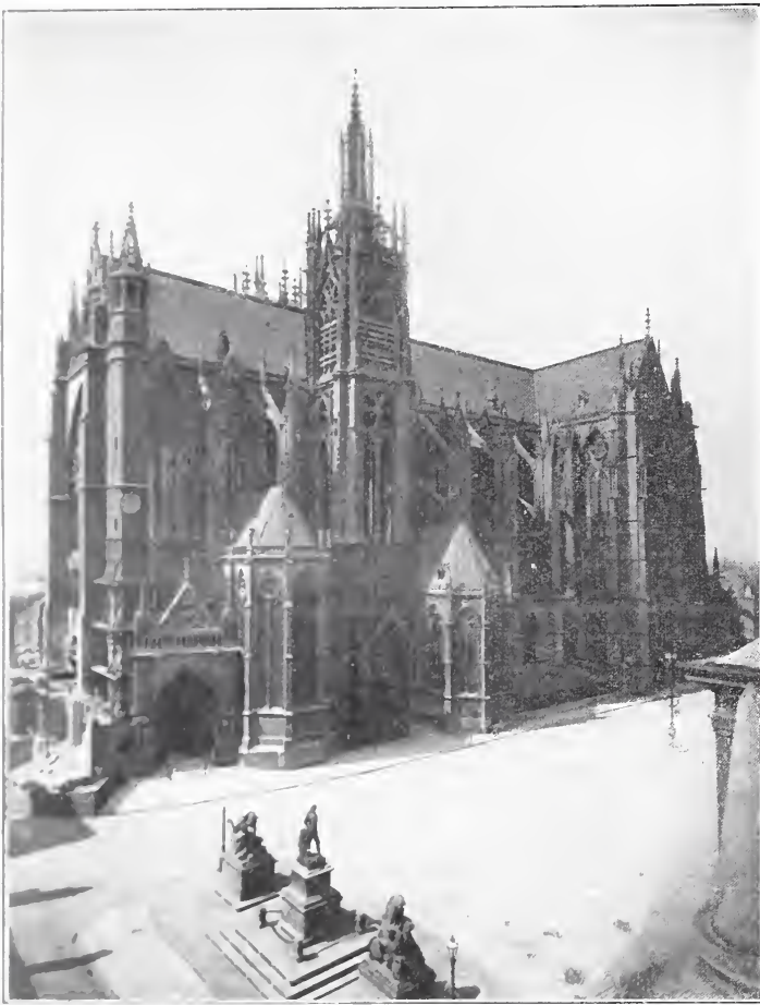
Abb. 1. Gesamtansicht von Süden her.
