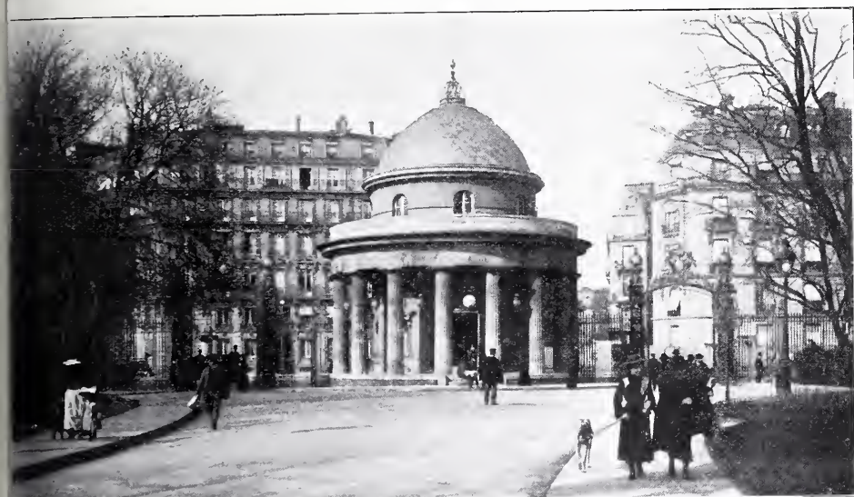
Abb. 1. Pavillon, daneben Ein- und Ausfahrt am Boulevard de Courcelles.
