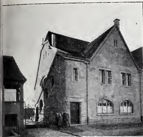
Abb. 13. Turnhalleneingang vom Hofe aus.
