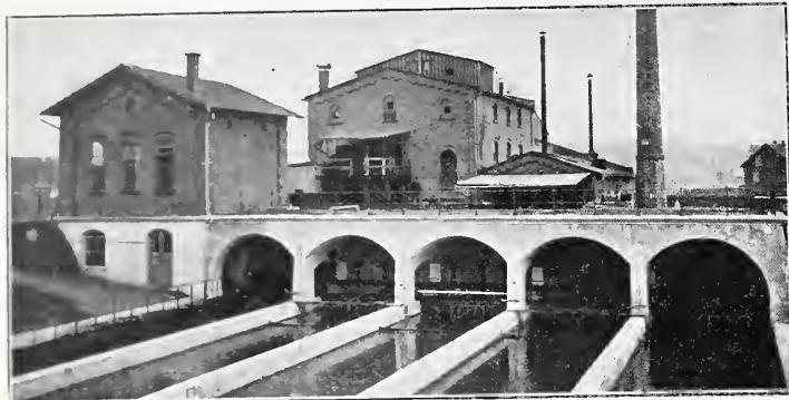
Abb. 7. Kläranlage in Kassel.
