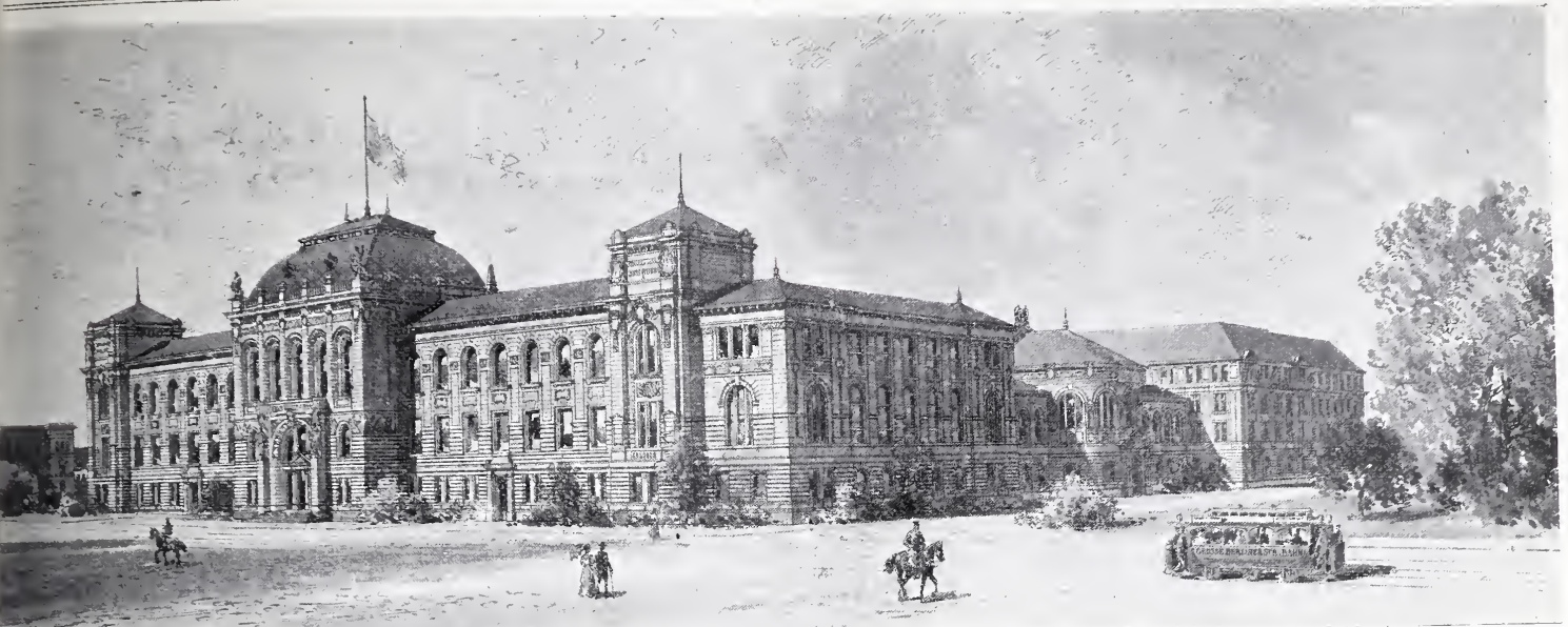
Abb. 4. Ansicht von Südosten.
