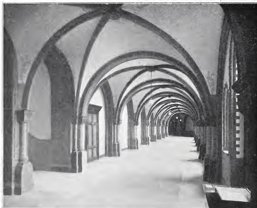
Abb. 5. Blick in den Hauptflur.
