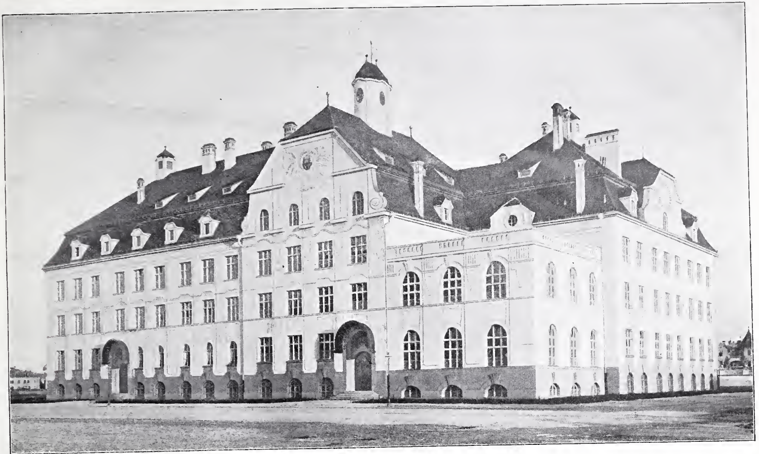
Abb. 3. Außere Ansicht. (Architekt: Städt. Baurat Hans Grässel in München.)
