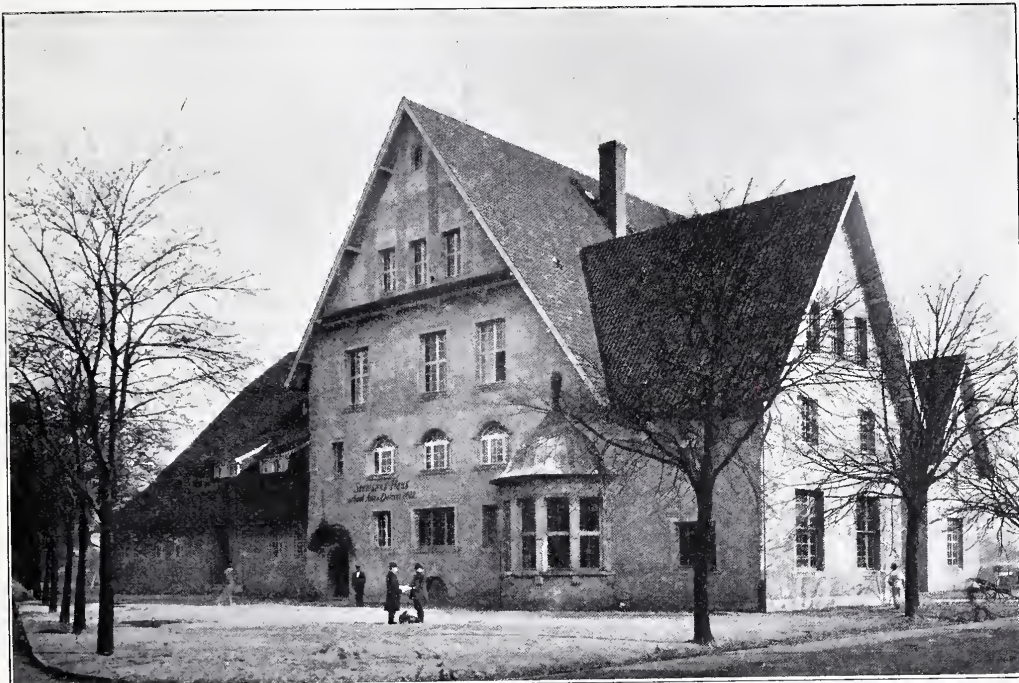
Abb. 8. Blick von Südwesten.
