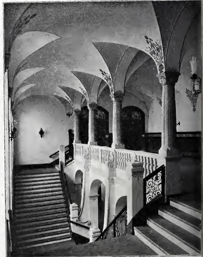
Abb. 5. Endigung der Haupttreppe und Vorhalle zur Aula.
