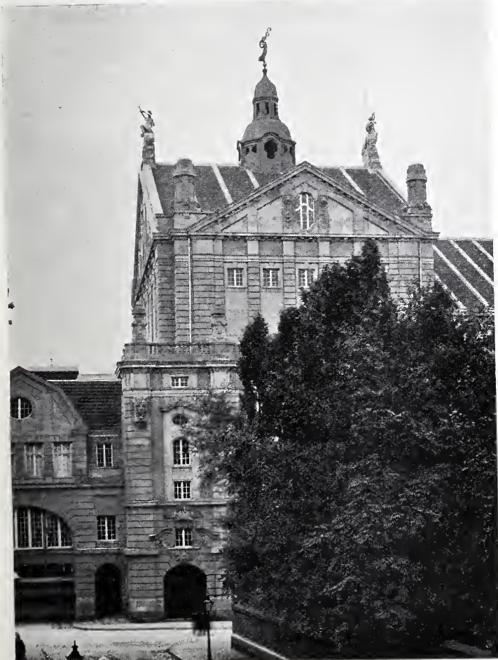
Abb. 3. Bühnenhaus und Ueberbrückung der Engelbertstraße.
