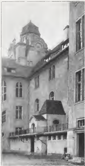
Abb. 10. Teil der Hofansicht von Norden her.
