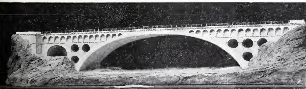
Abb. 11. Syratalbrücke in Plauen.
