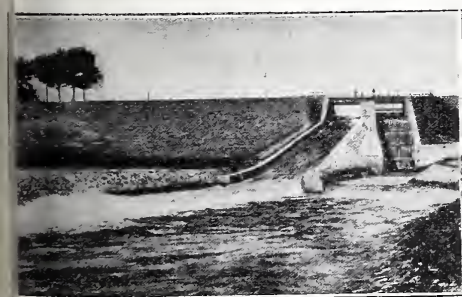
Abb. 1. Neue Mühlhof-Schleuse. Geöffnete Floßschleuse.
