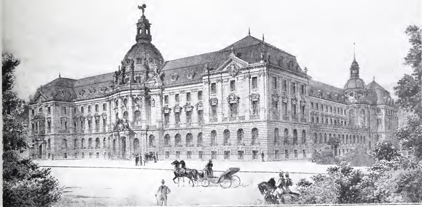
Abb. 6. Neues Regierungsgebäude in Potsdam.
