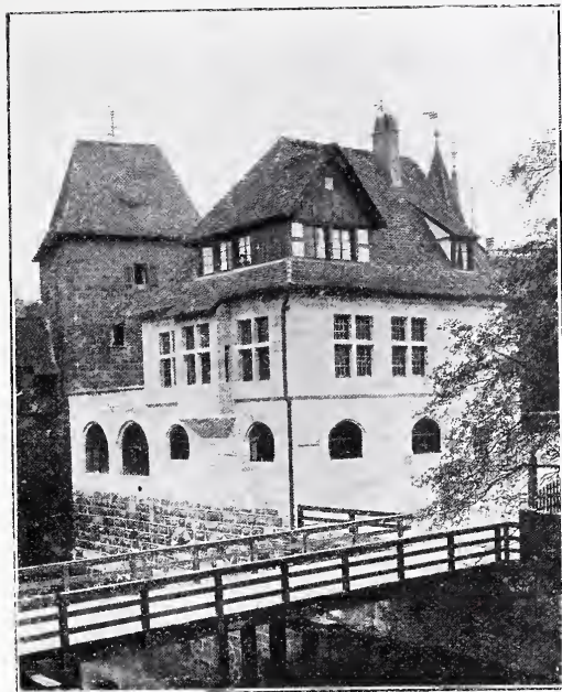
Abb. 5. Ansicht von Nordwesten.
