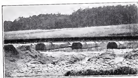
Abb. 4. Ausspülungen der Sandbettung durch das Hochwasser vom 6. Juli 1899.
