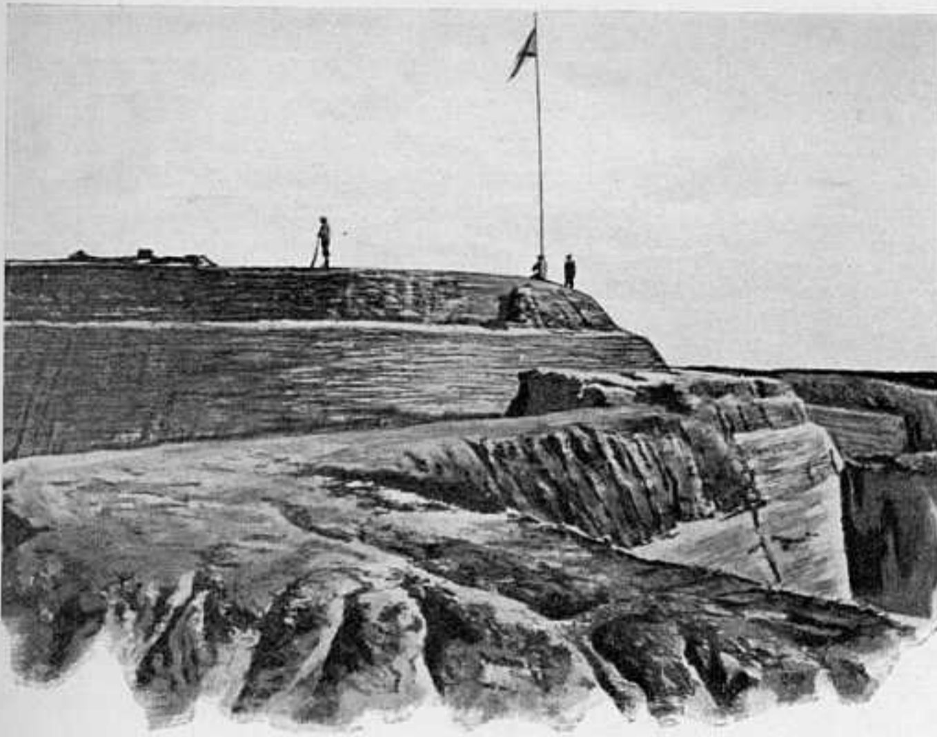
КРѢПОСТЬ ИНКОУ. ФОРТЪ ПРИ УСТЬѢ РѢКИ ЛЯОХЭ.
