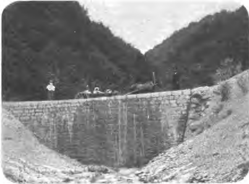
Каменный лотокъ на Шатоевскомъ шоссе.
