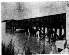
(10) 修復之第二號橋
