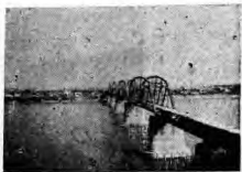
(8) 修復之山下渡橋
