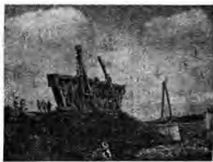
(13) 第十一號吊裝新式 木桁梁
