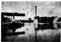
(12) 第十一號橋吊裝鋼梁
