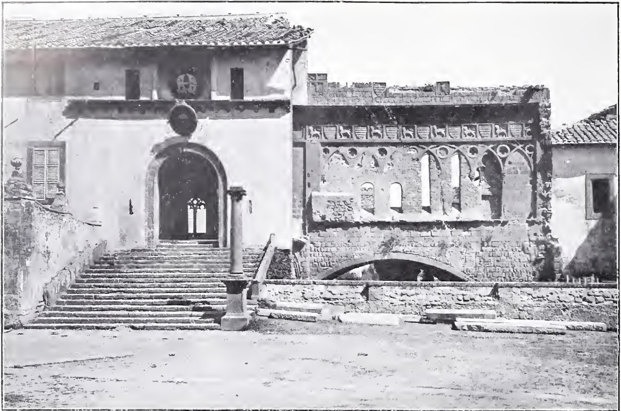
VITERBO, DIE PÄPSTLICHE LOGGIA UND DER SAAL DES KONKLAVES VOR DER RESTAURIERUNG (Photographie des italienischen Unterrichtsministeriums)
