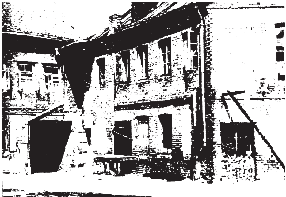
„Koperciarńia” przy ul. Brukowej
