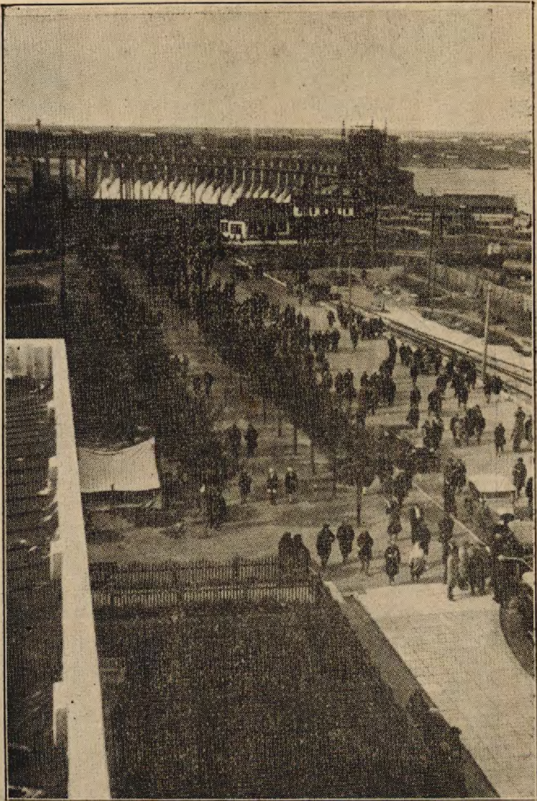
鄧尼泊羅水電站之啓用，圖示鄧尼泊羅水電站之全景，顯示鄧尼潑河之兩岸和新建築之概觀，所謂新建築是指工廠與工人宿舍等，而又全依賴此高度發電站所推動的。
