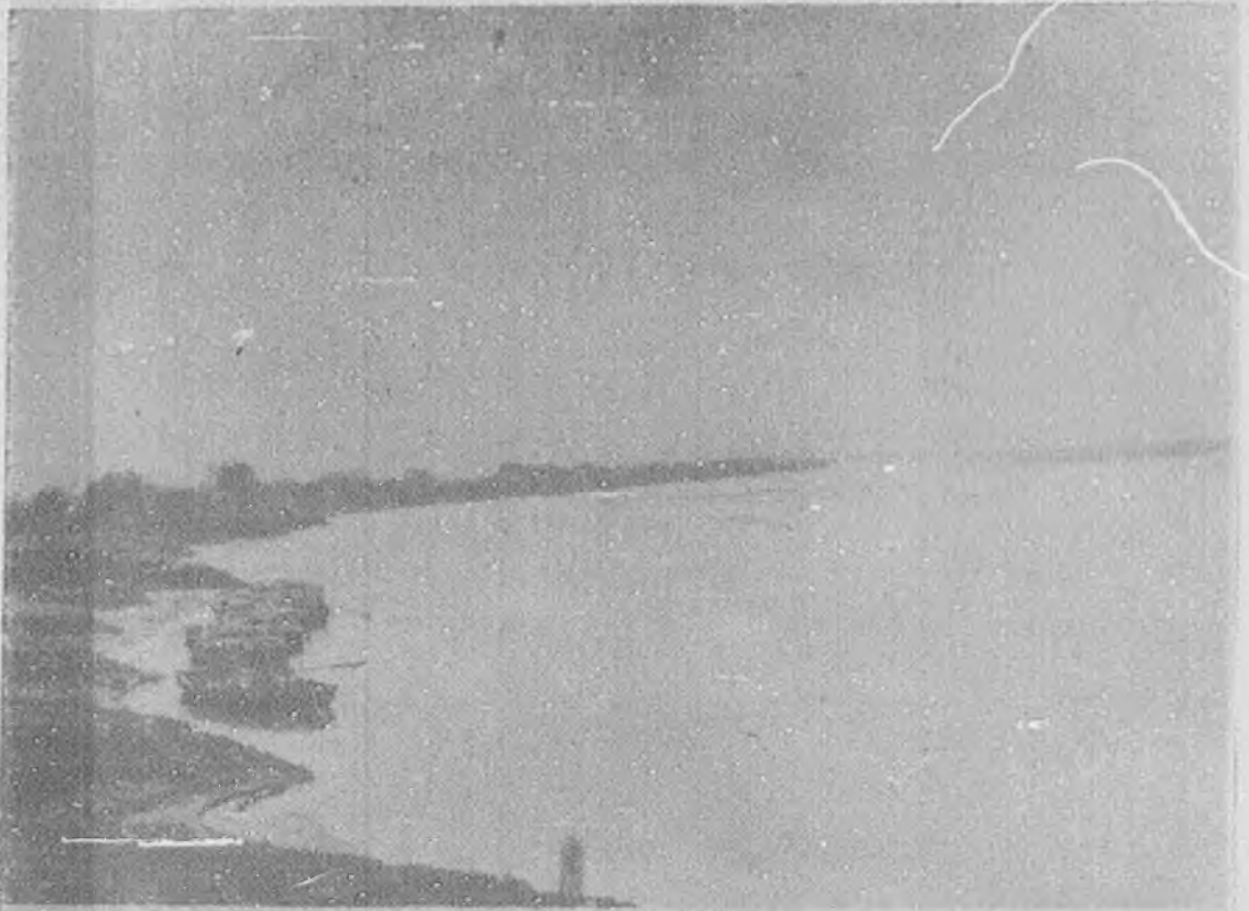
孟津謝鎮漢陵堤之護岸石工
