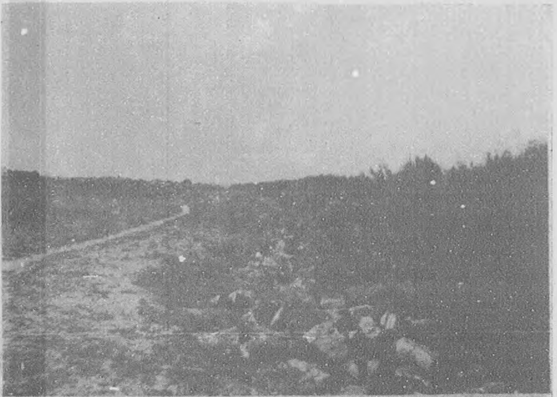
黄河大堤外之扇面壩 (護岸工程)
