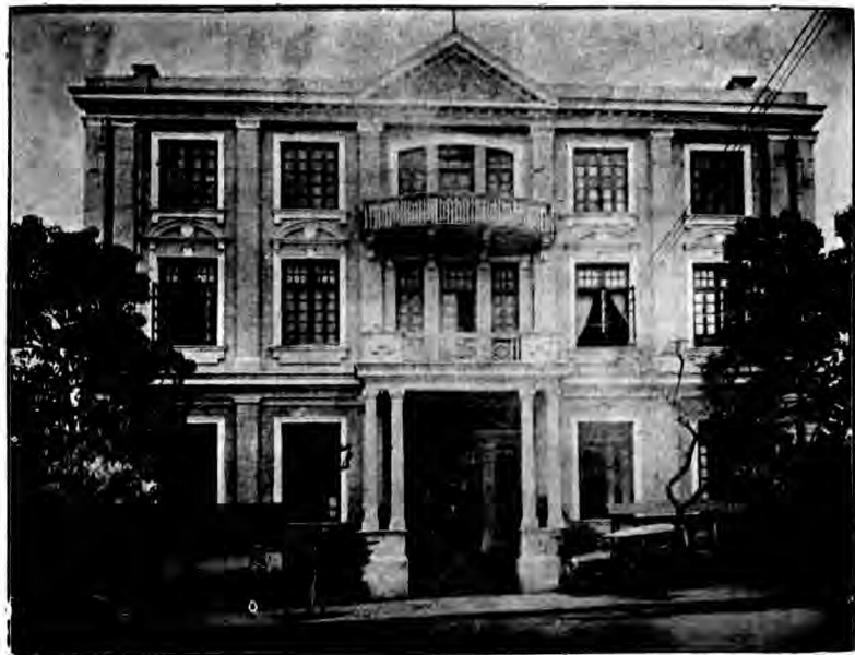
廣東省建設廳正門
