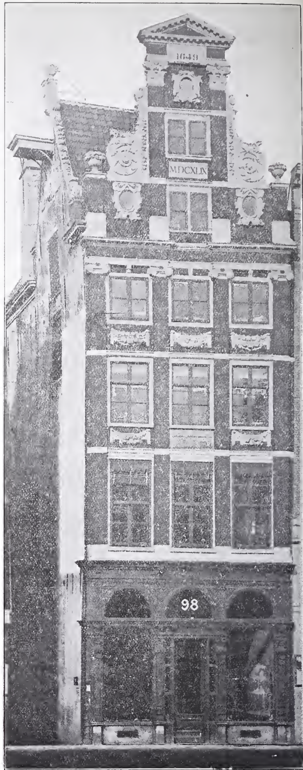
Afgebroken gebouw van 1649.
