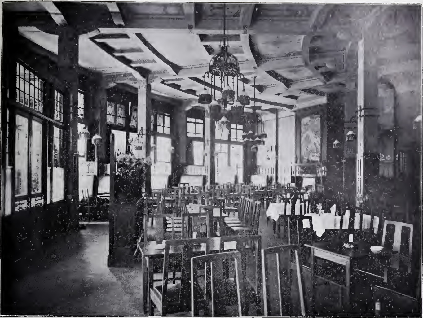
BENEDENZAAL VAN HET RESTAURANT-STATION DER Z. H. E. S. M. TE ROTTERDAM.
