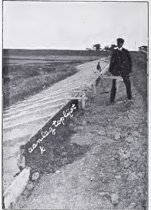
Fig. 16. Aanleg van de toplijst van het balkenstelsel.
