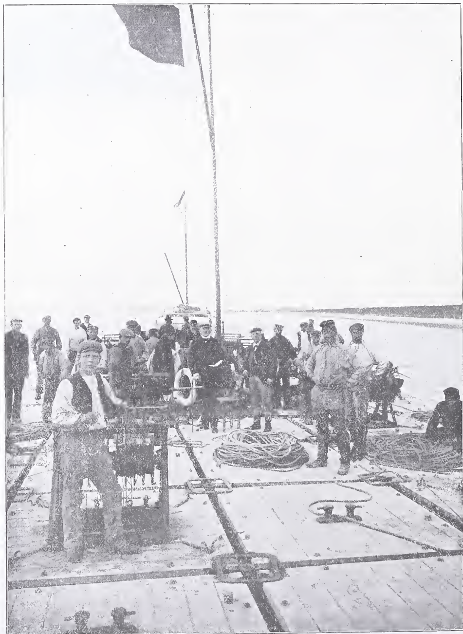
Fig. 23. Gedeeltelijk gezicht op den gemonteerden drijver.
