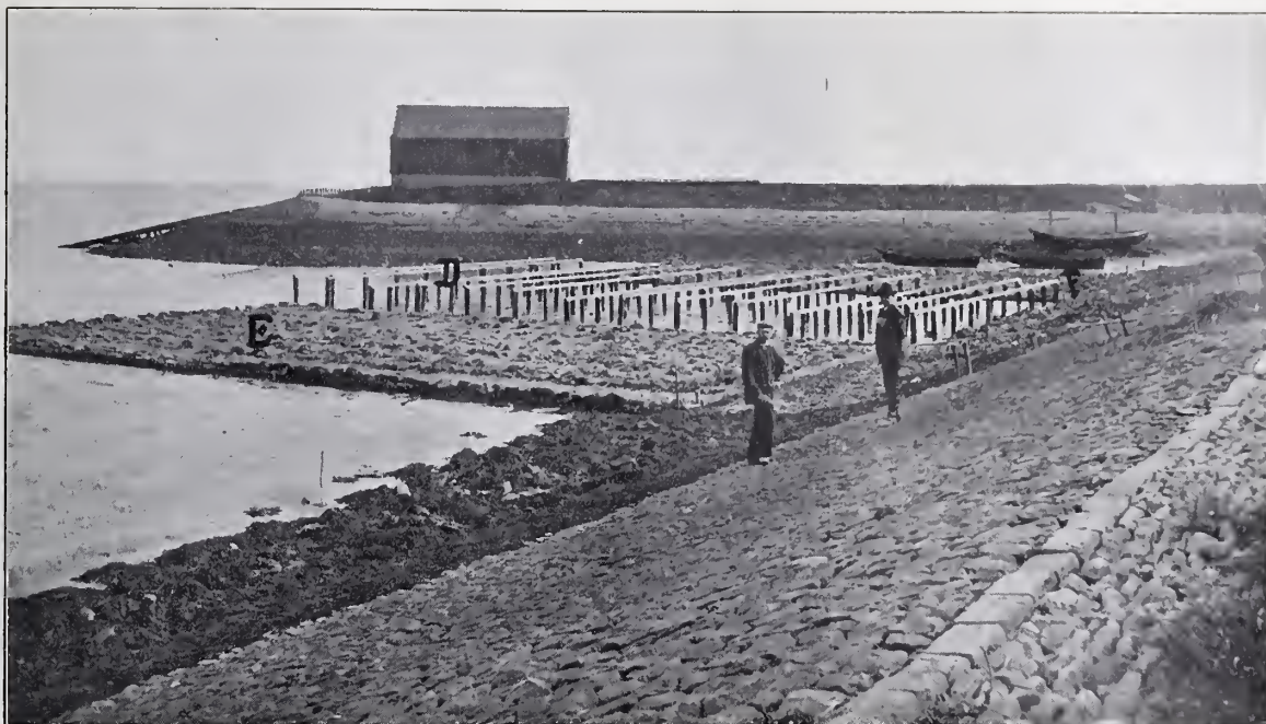
Fig. 8. De montageplaats bedekt met rijshout.
