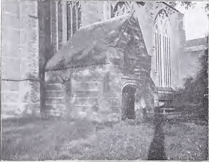
Portaal W.zijde van de kerk te Brouwershaven.
