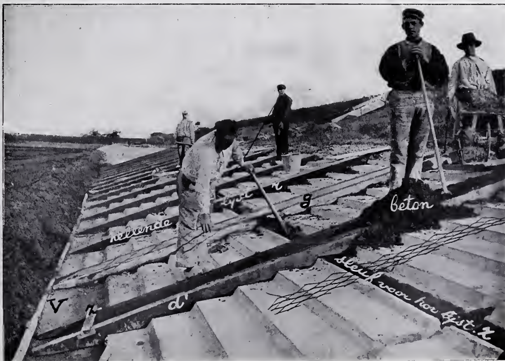
Fig. 14. Aanleg van de hellende lijsten.
