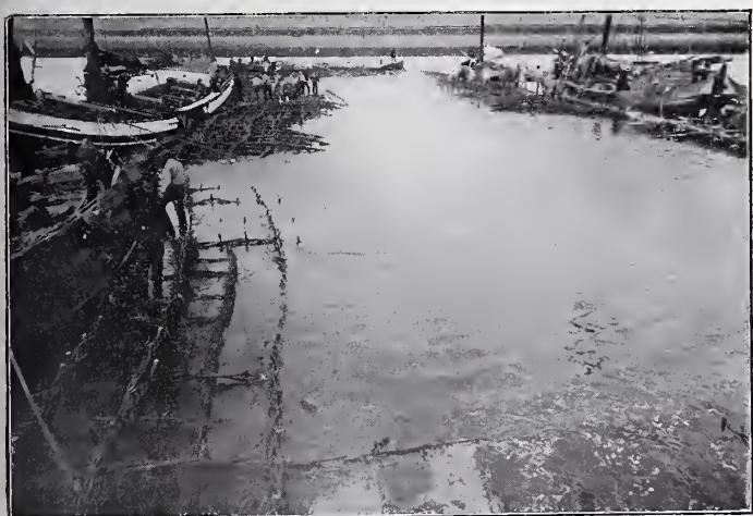
Fig. 2. Het rijszinkstuk voor het grootste deel geballast.
