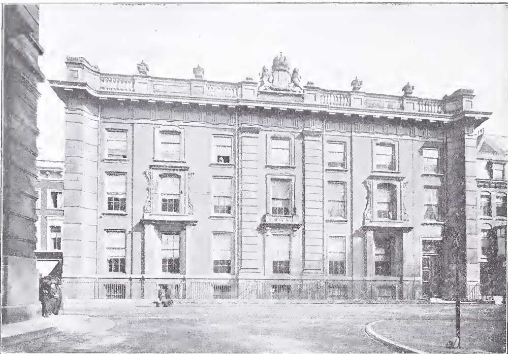
Het voormalig Rijks-Archiefgebouw.
