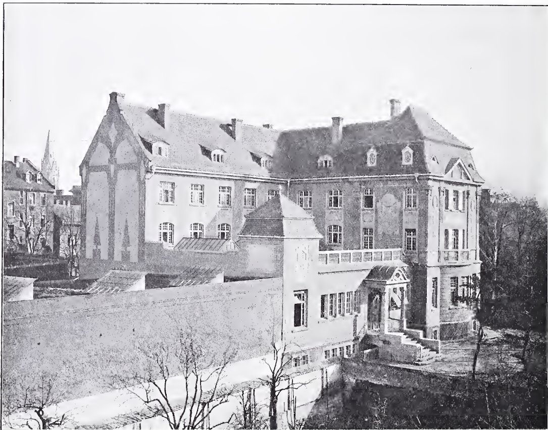
Administratie gebouw der Ortskrankenkasse.
