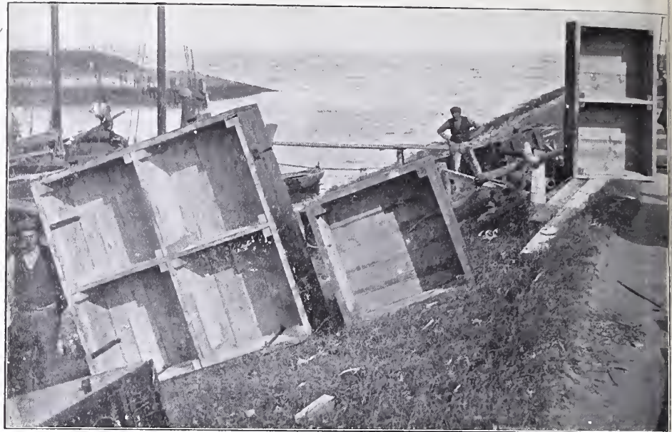
Fig. 13. Gezicht op de drie vormen van de bakken in 'aanmaak. De deksels zijn nog niet aangebracht.
