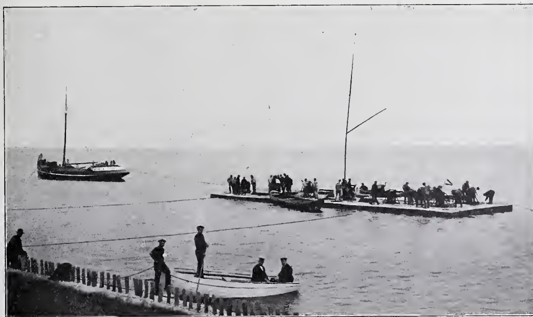
Fig. 29. De drijver met betonzinkstuk wordt gesleept naar de plaats van zinken.
