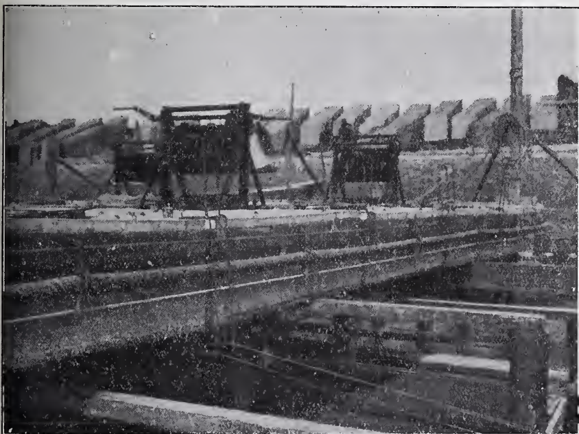
Fig. 27. De draden worden door haken opgehouden om verward raken te voorkomen.
