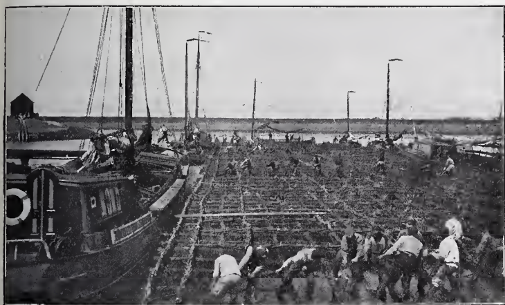
Fig. 1. Het ongeballaste Rijszinkstuk ligt in de Raaien op de plaats van zinking.
