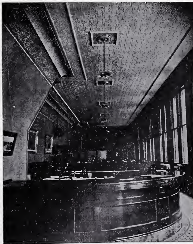
„Steleonite” Plafond in een Bankgebouw.
