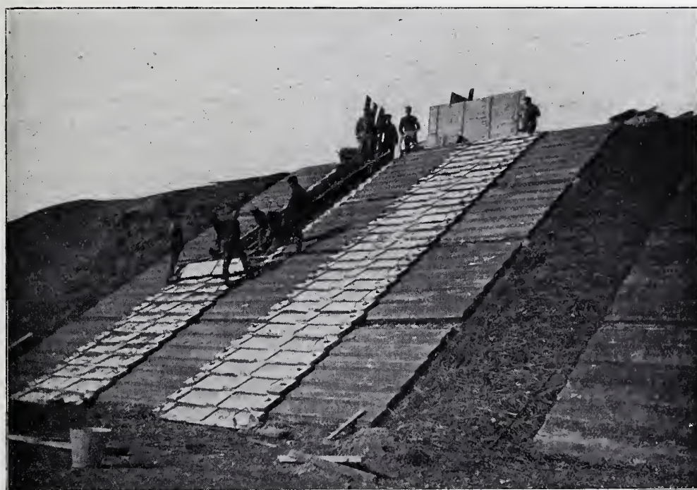
Fig. 19. Het maken van platen op een talud steiler dan een op een. (Gedeeltelijke kanaaloever in harde klei.)
