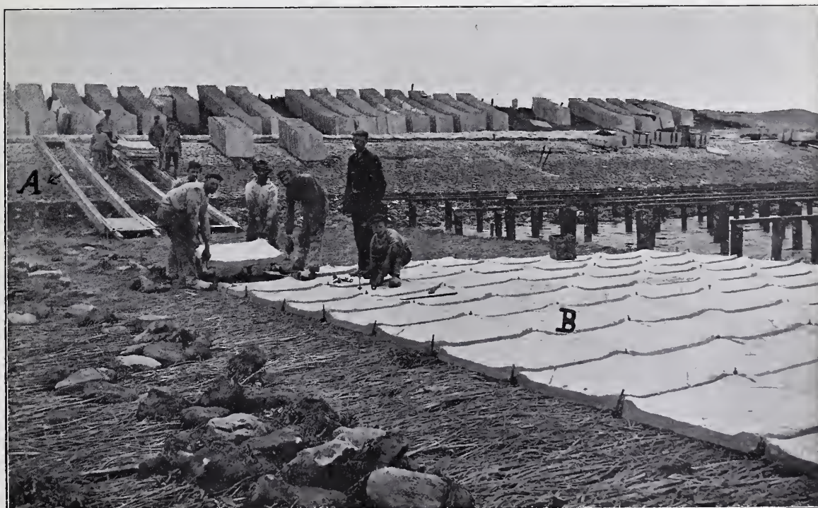
Fig. 9. Het monteeren van een betonzinkstuk.
