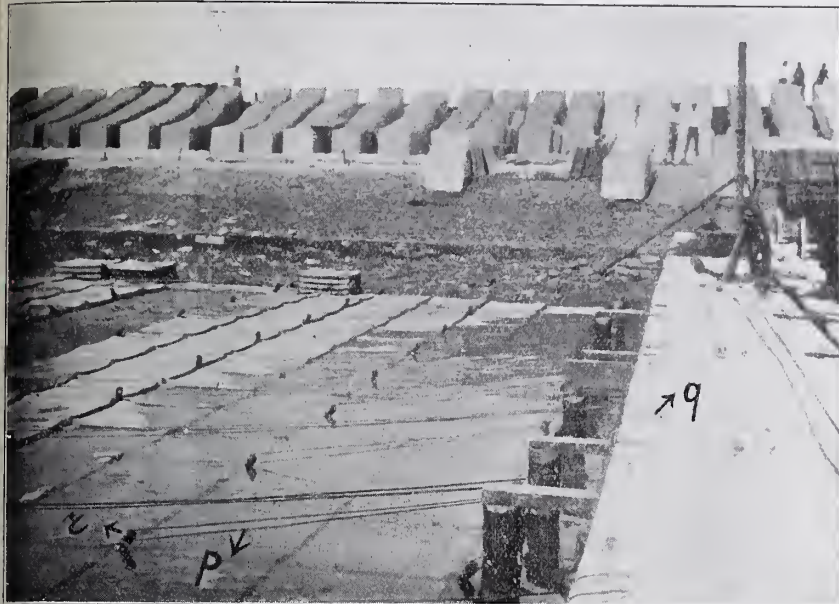
Fig. 26. Afbeelding van den rand van den drijver en gericht op de verbindingsdraden. (De staaldraden P zijn 6 m.M. dik en kunnen 5000 KG. dragen.
