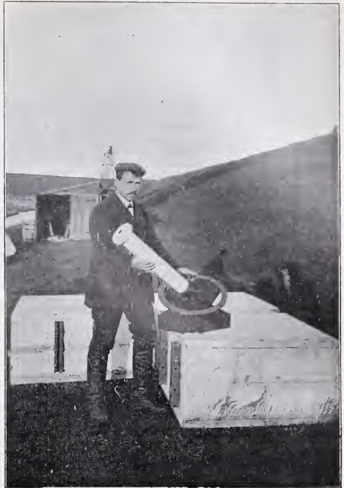
Fig. 20. Knooppunttoestel van den proefdrijver met eikenhouten verlengkoker.
