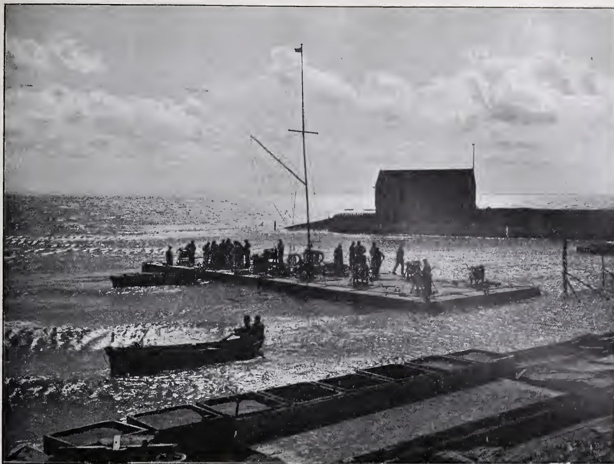
Fig. 28. De drijver verdreven boven het betonzinkstuk. Het betonzinkstuk wordt hierop onder tegen den drijver aangetrokken.
