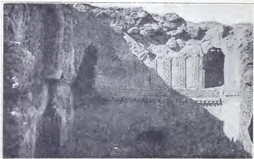
Fig. 152. — Détail d'un palais à Sedrata (Algérie) (niches côtéées servant de trompes aux angles de la table), x<sup>e</sup> siècle.
