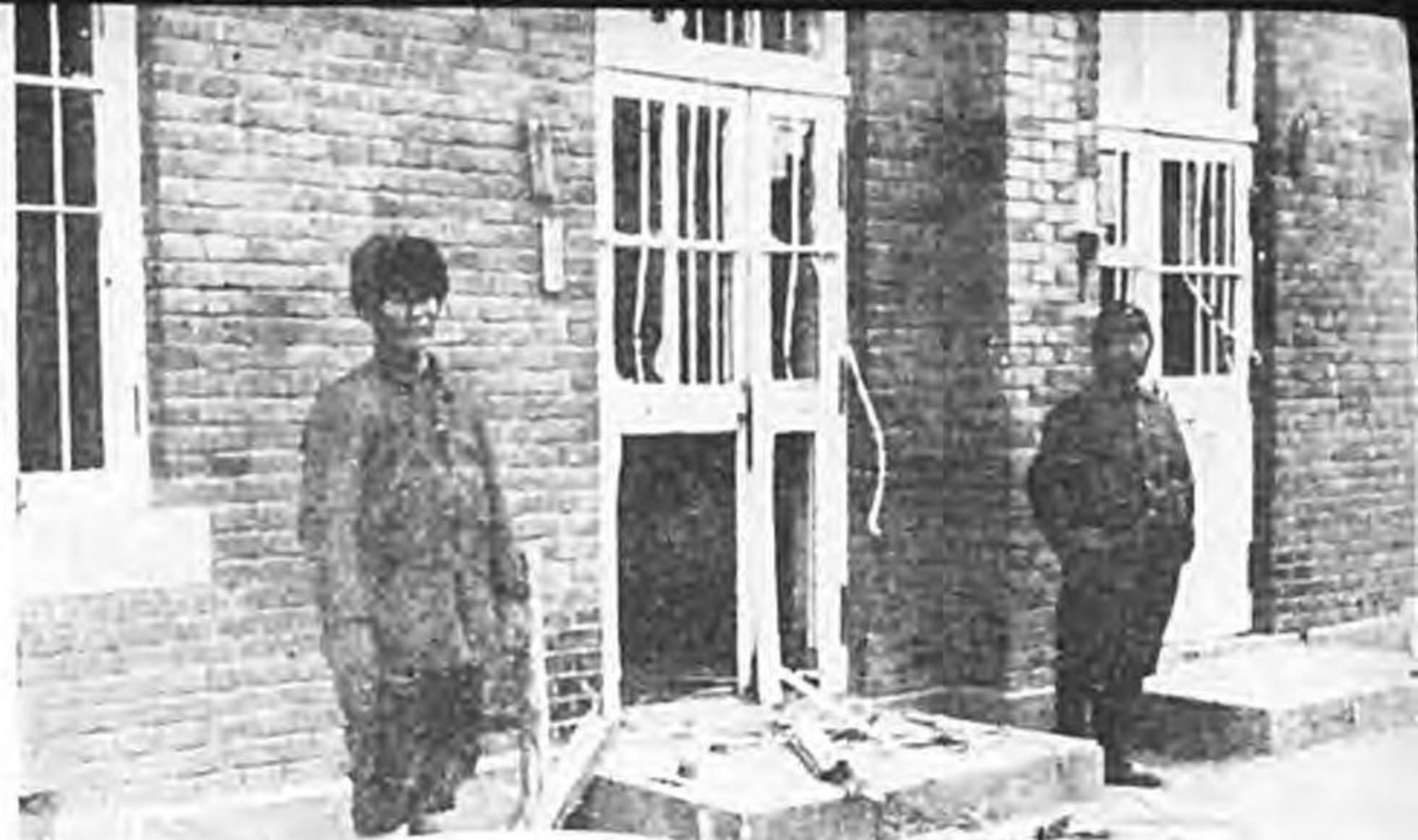
(上) 匪賊の兵に破壊された滿鐵社宅
