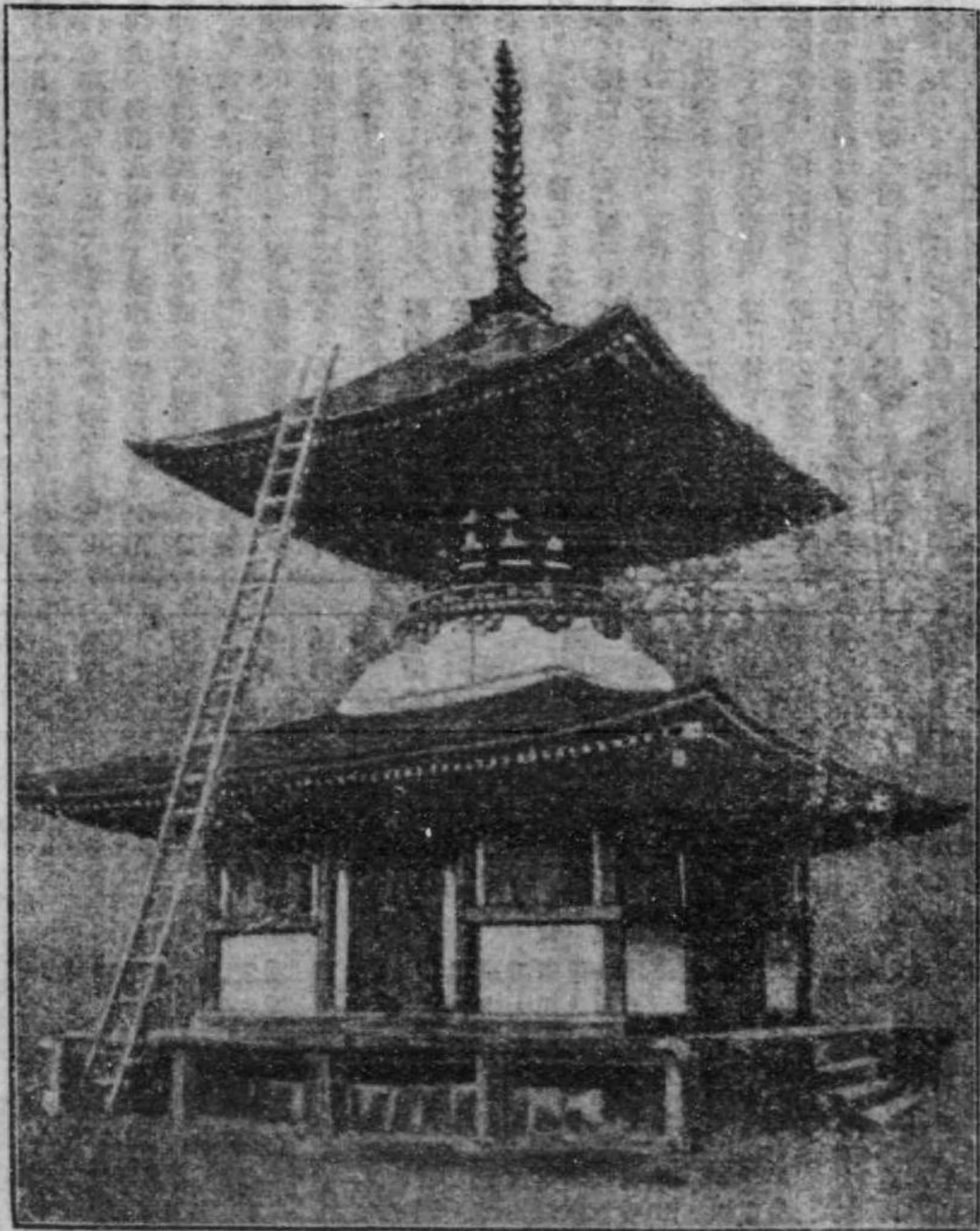
多寶塔 (高野山東塔)
