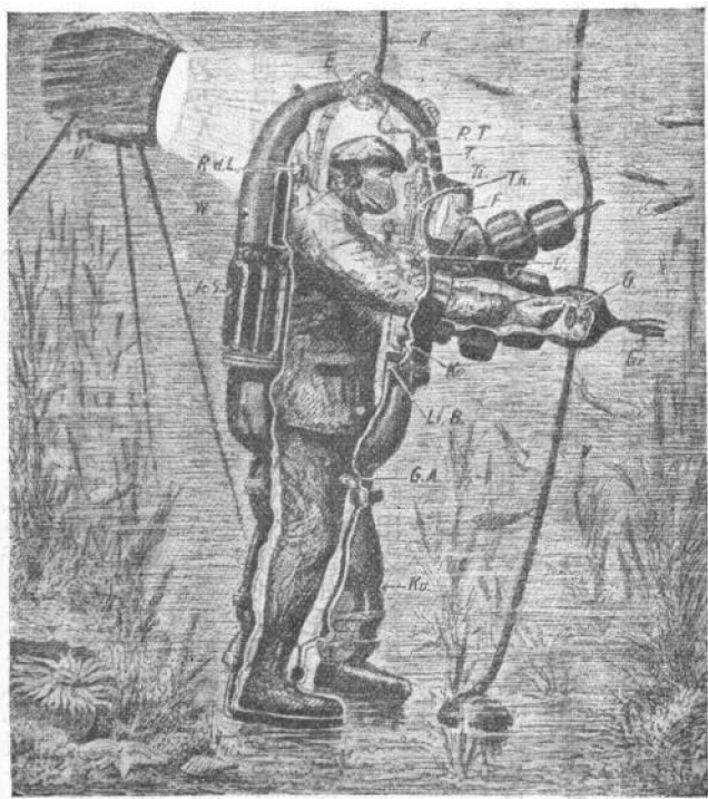
第七圖 深海潛水器之內部構造
