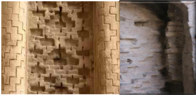
تصویر ۸. تزئین آجری لوزی در شبستان مسجد جامع اصفهان. ۱ تصویر ۹: آجرچینی لوزی در مسجد جورجیر اصفهان. ۲
