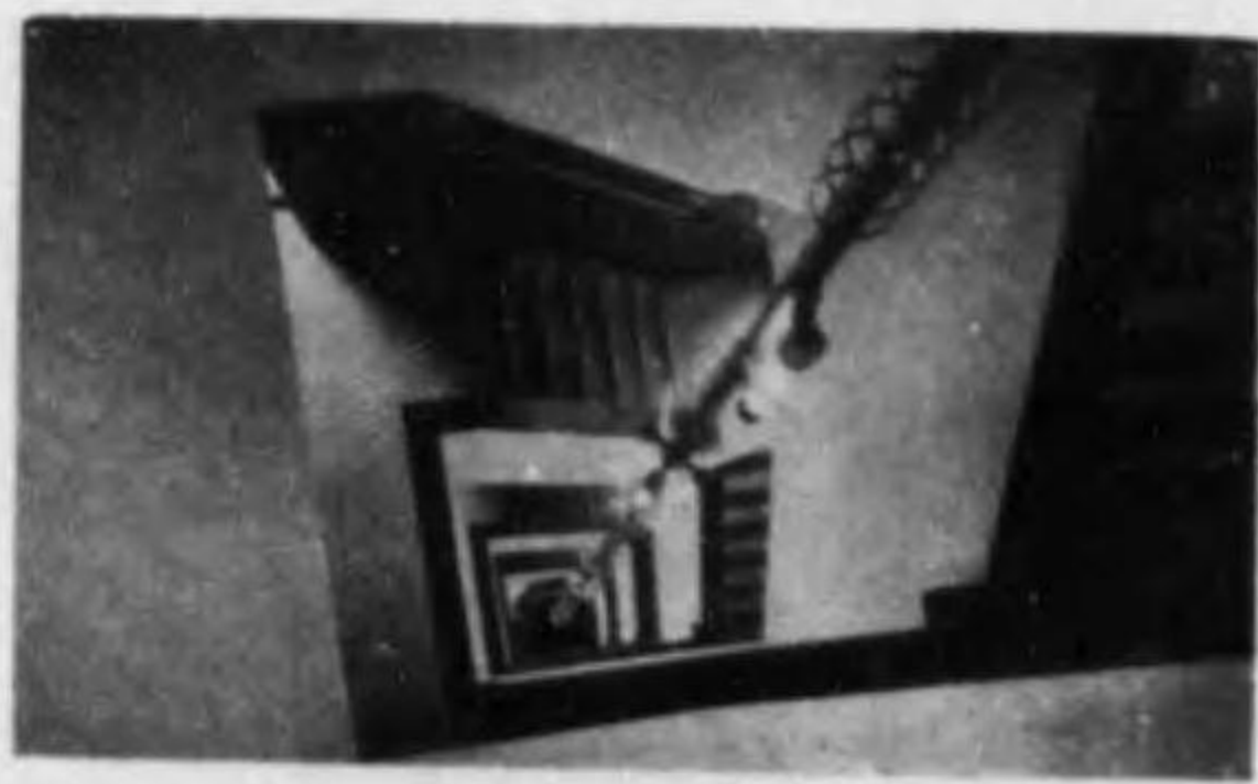
電氣科學館階段の照明
