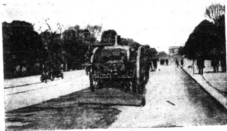
第 100 圖 壓力瀝青澆注器
