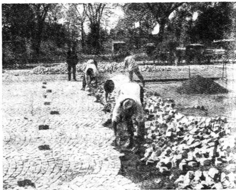
第 97 圖 立 方 石 塊 之 施 工
