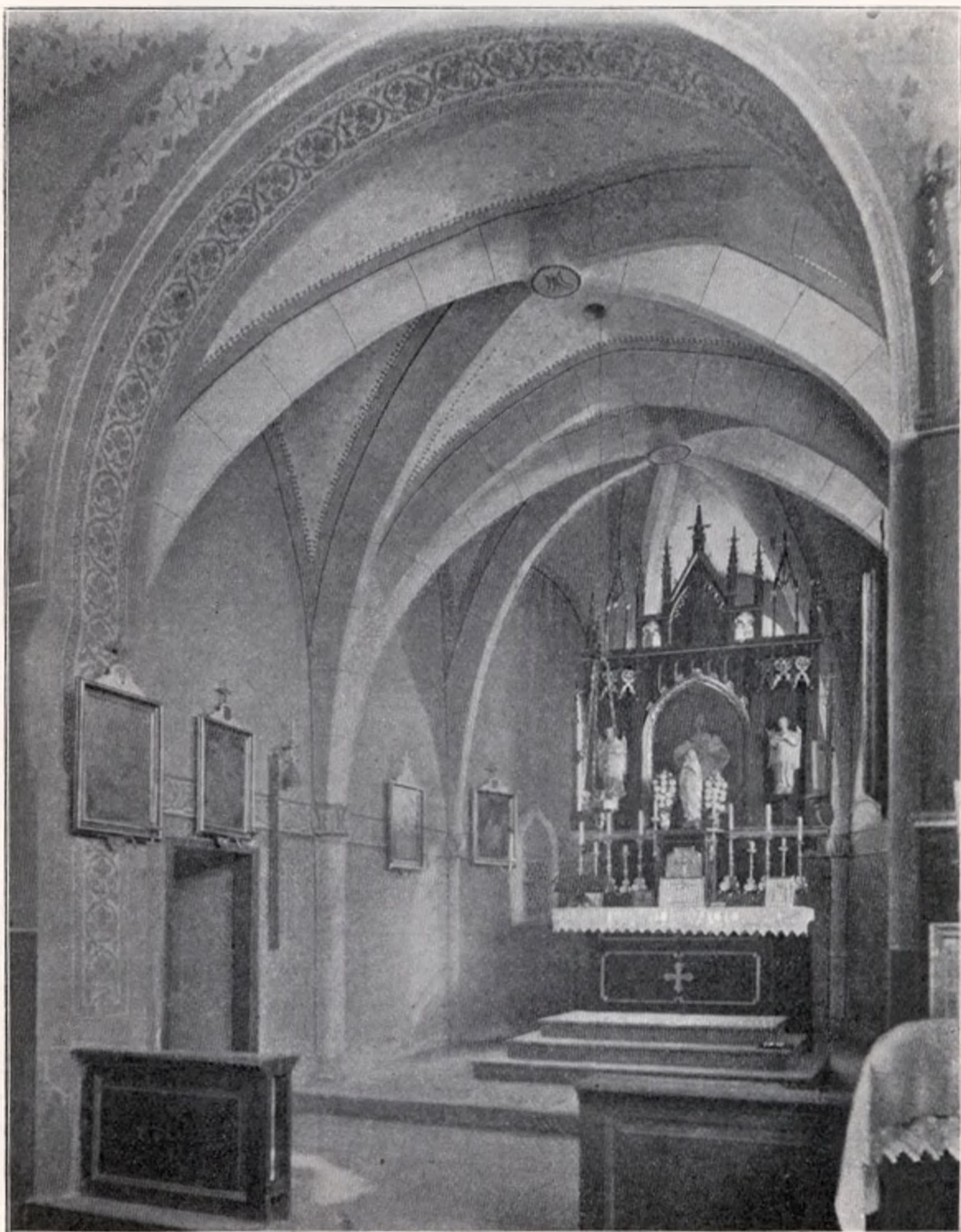
Obr. 207. Višňová. Pohled do presbytáře.
