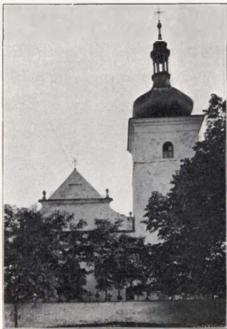
Obr. 181. Slivice. Pohled na kostel.
