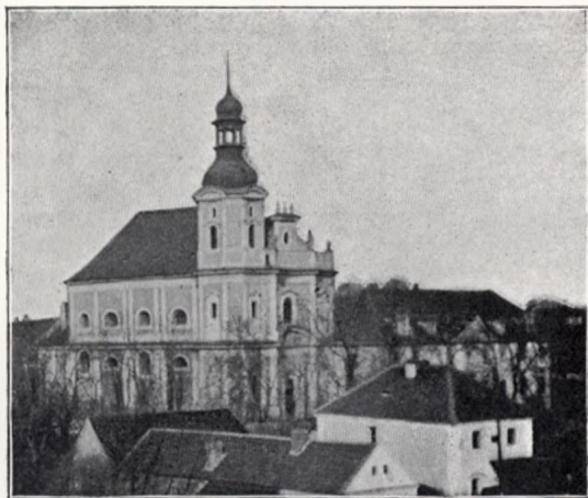
Obr. 91. Obořiště. Pohled na kostel od jihovýchodu.
