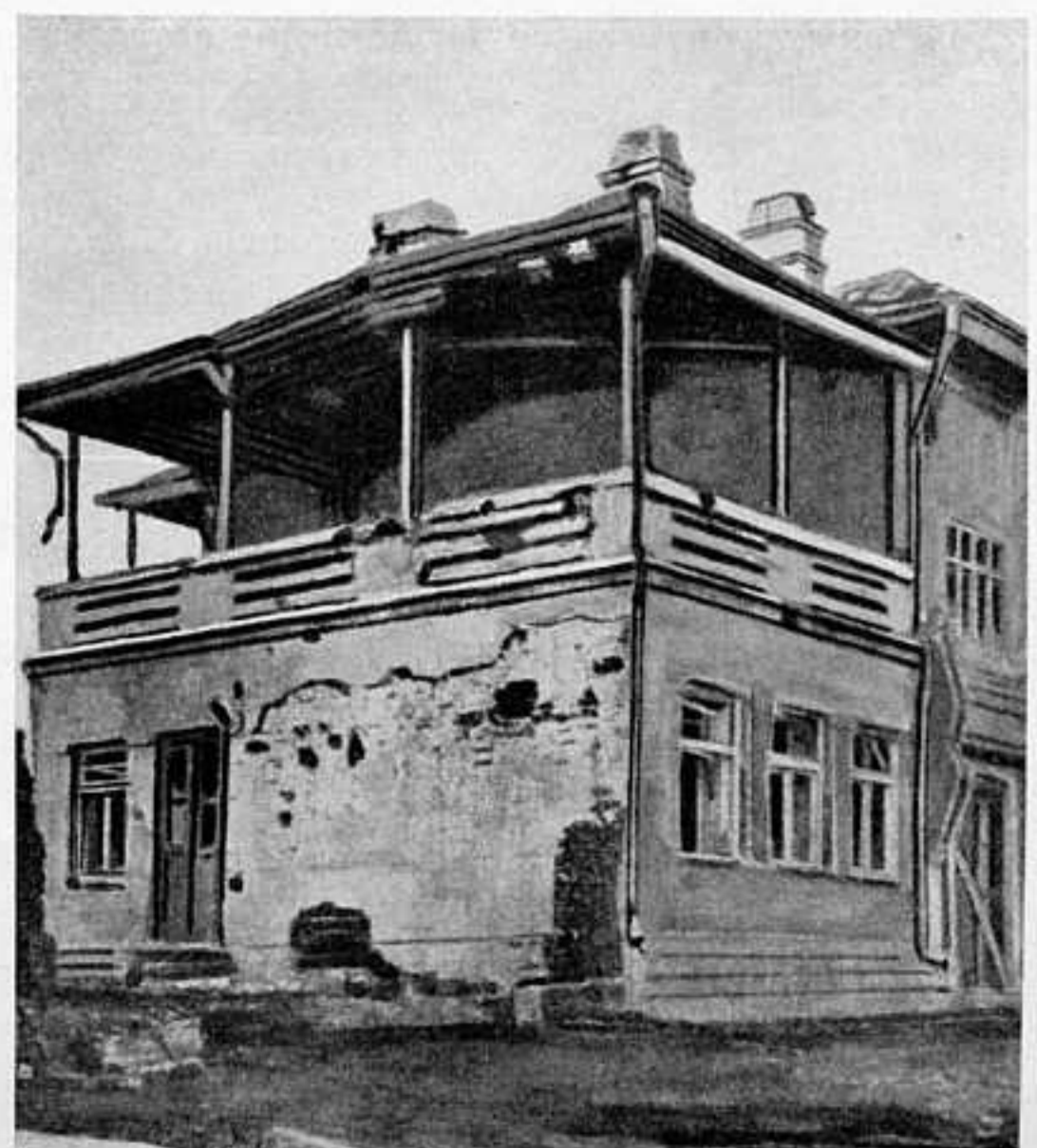
ПОВРЕЖДЕННОЕ БОМБАРДИРОВКОЙ ЗДАНИЕ ВЪ ПОРТЪ-АРТУРЪ.
