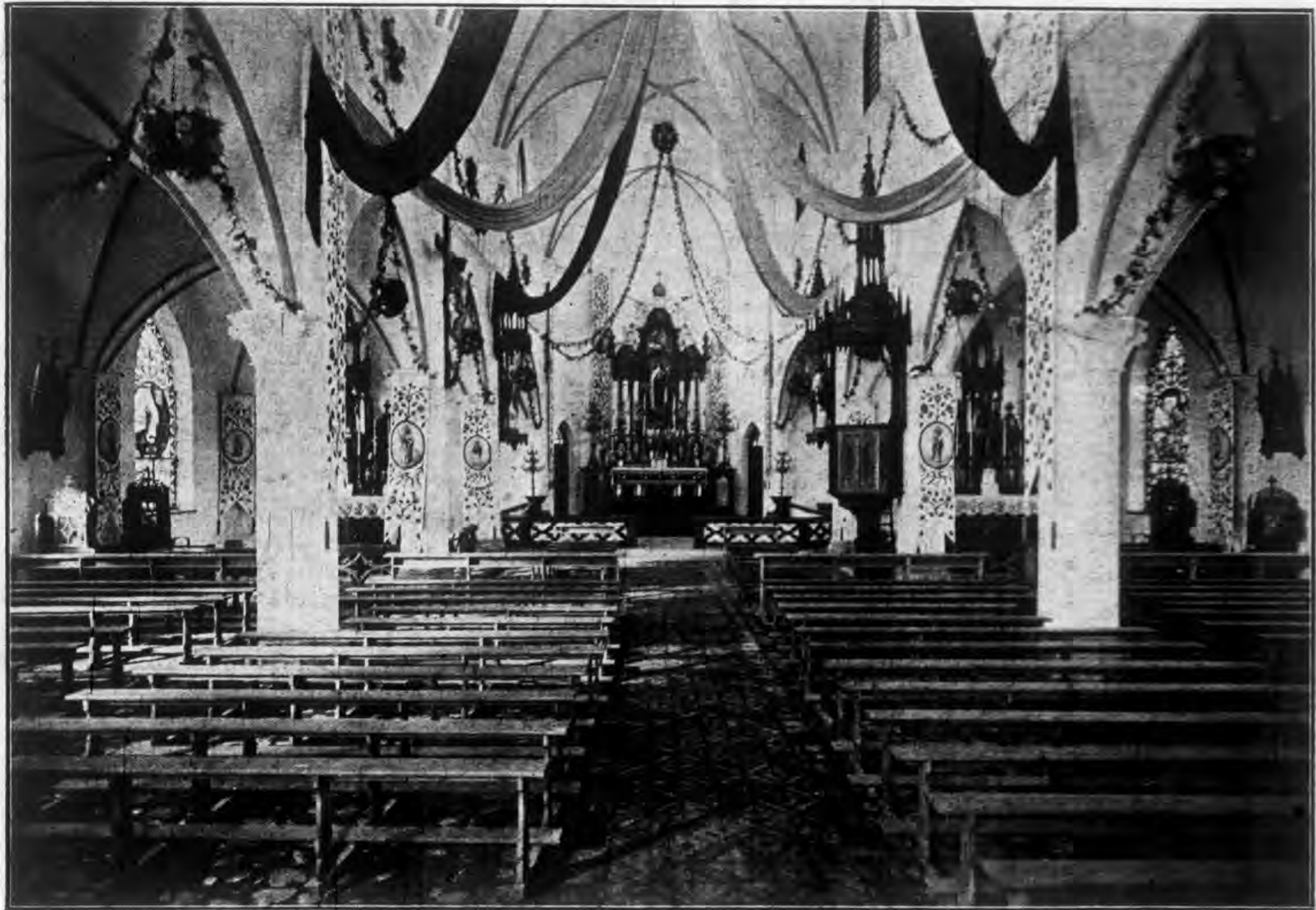
江蘇海門曹家鎮新建嬰德堂
