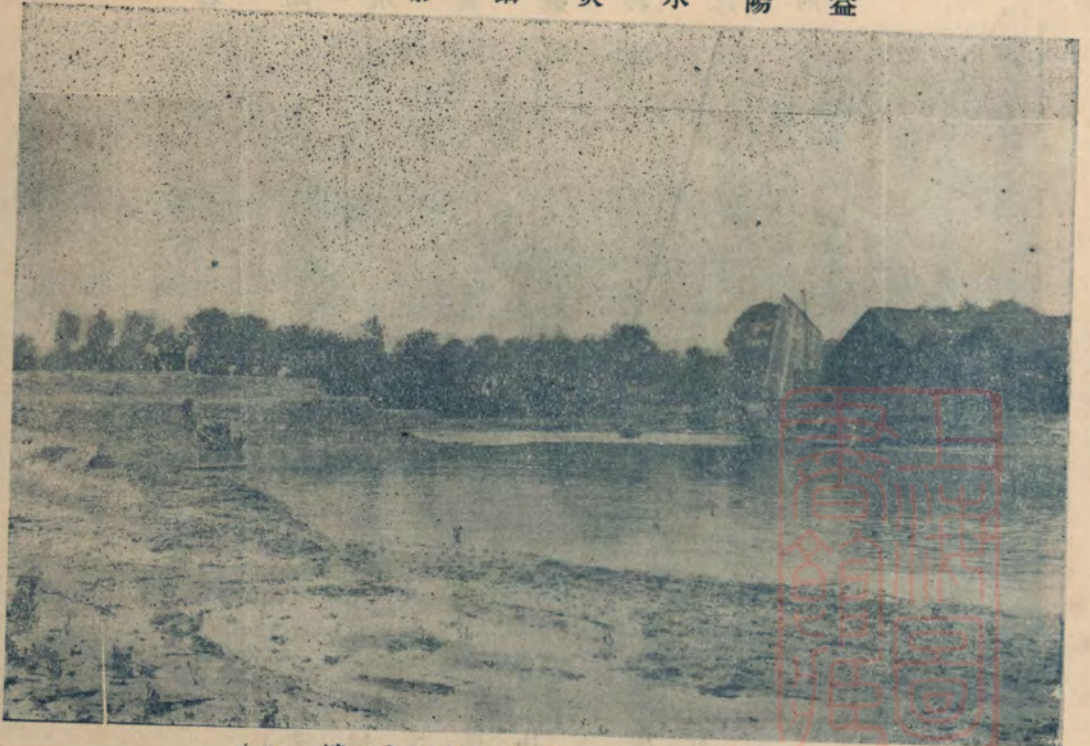
( 三堡沙頭巷堤防之潰口 )
