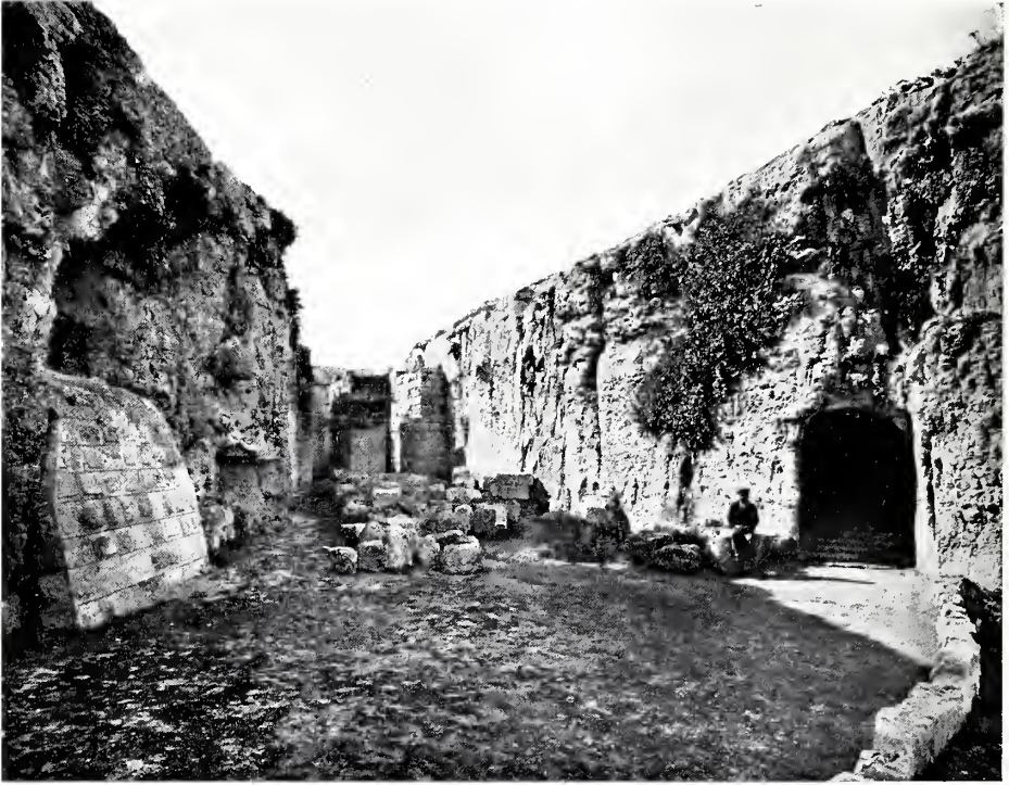
CASTELLO EURIALO — IL TERZO FOSSATO.
