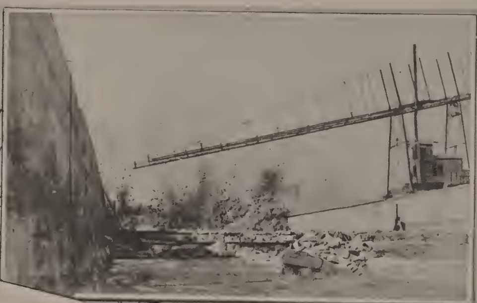
1000 LB. DYNAMITE BLAST.
