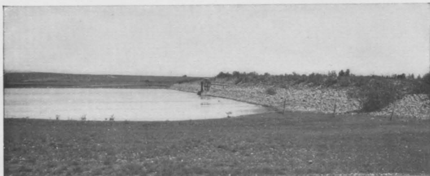
FIG. 1.—WINDSOR RESERVOIR, COLORADO.
