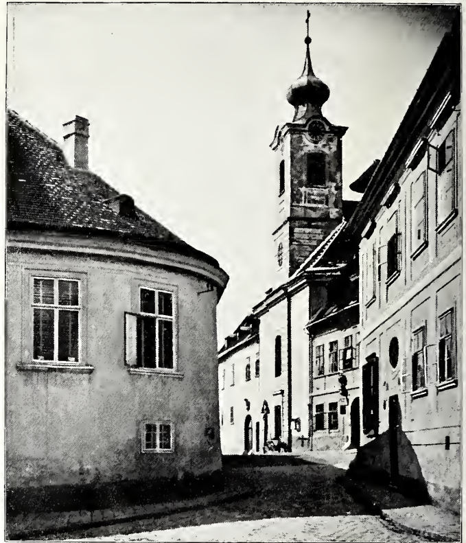
Fig. 570 Nußdorf, Greinergasse Nr. 24, hinten Pfarrkirche (S. 452)
