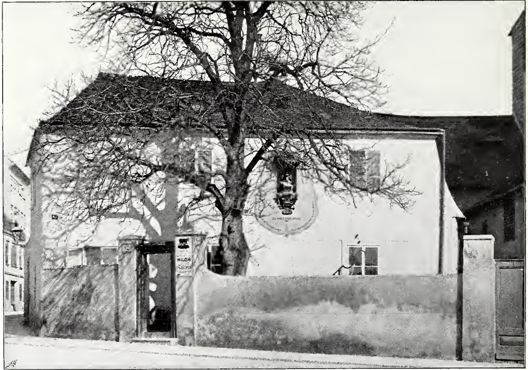
Fig. 112 Penzing, Penzingerstraße Nr. 92 (S. 99)
