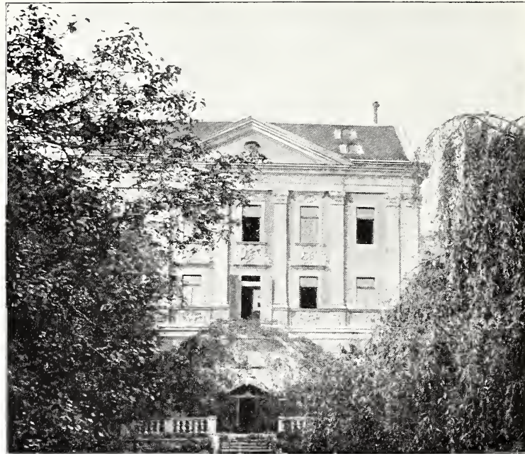
Fig. 581 Nußdorf, Gartenfront des Hauses Hackhofergasse Nr. 18 (S. 462)
