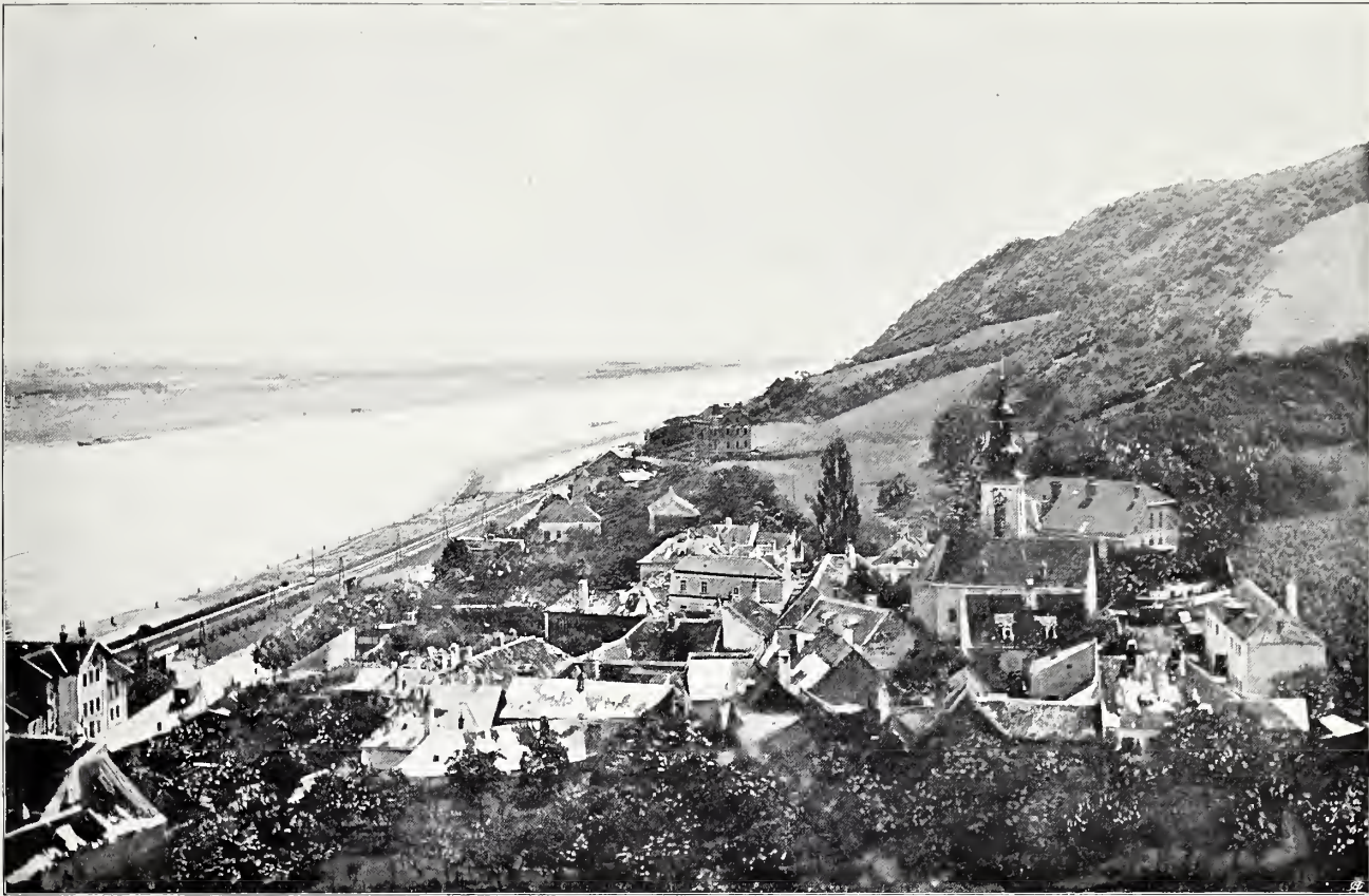
Fig. 551 Kahlenbergdorf, Gesamtansicht (S. 434)
