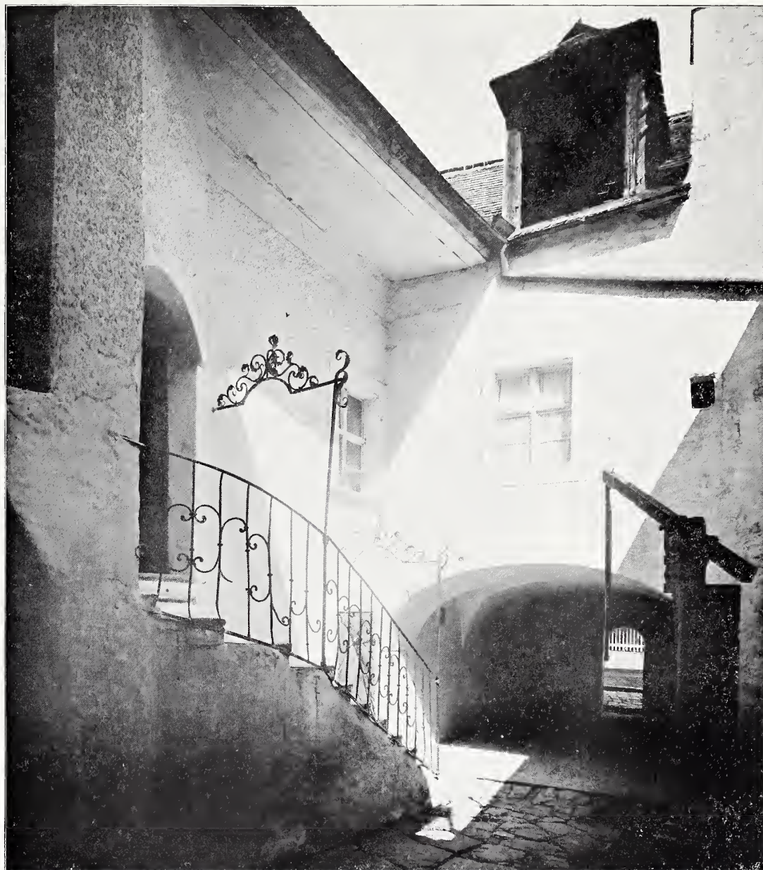
Fig. 502 Grinzing, Hof des Hauses Himmelstraße Nr. 31 (S. 401)
