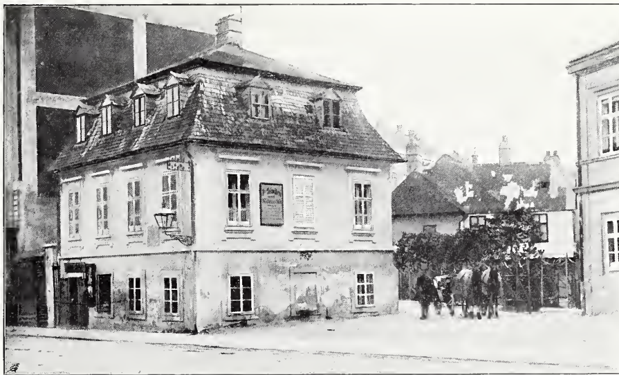
Fig. 75 Hietzing, Lainzerstraße Nr. 21 (S. 71)
