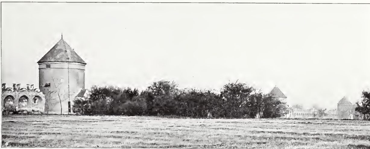
Fig. 27 Neugebäude, westliche Umfassungsmauer (S. 24)
