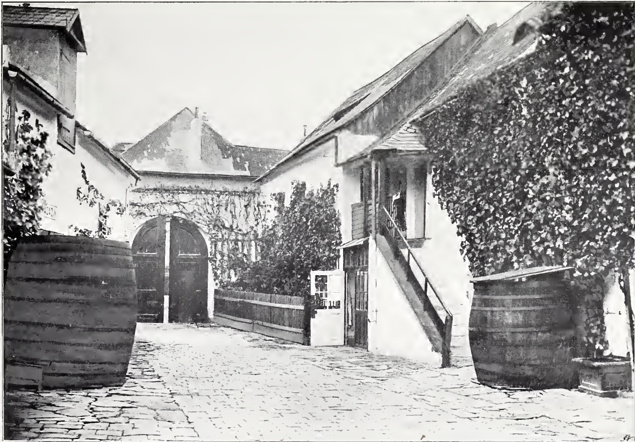
Fig. 519 Heiligenstadt, Hof des Hauses Pfarrplatz Nr. 2 (S. 413)
