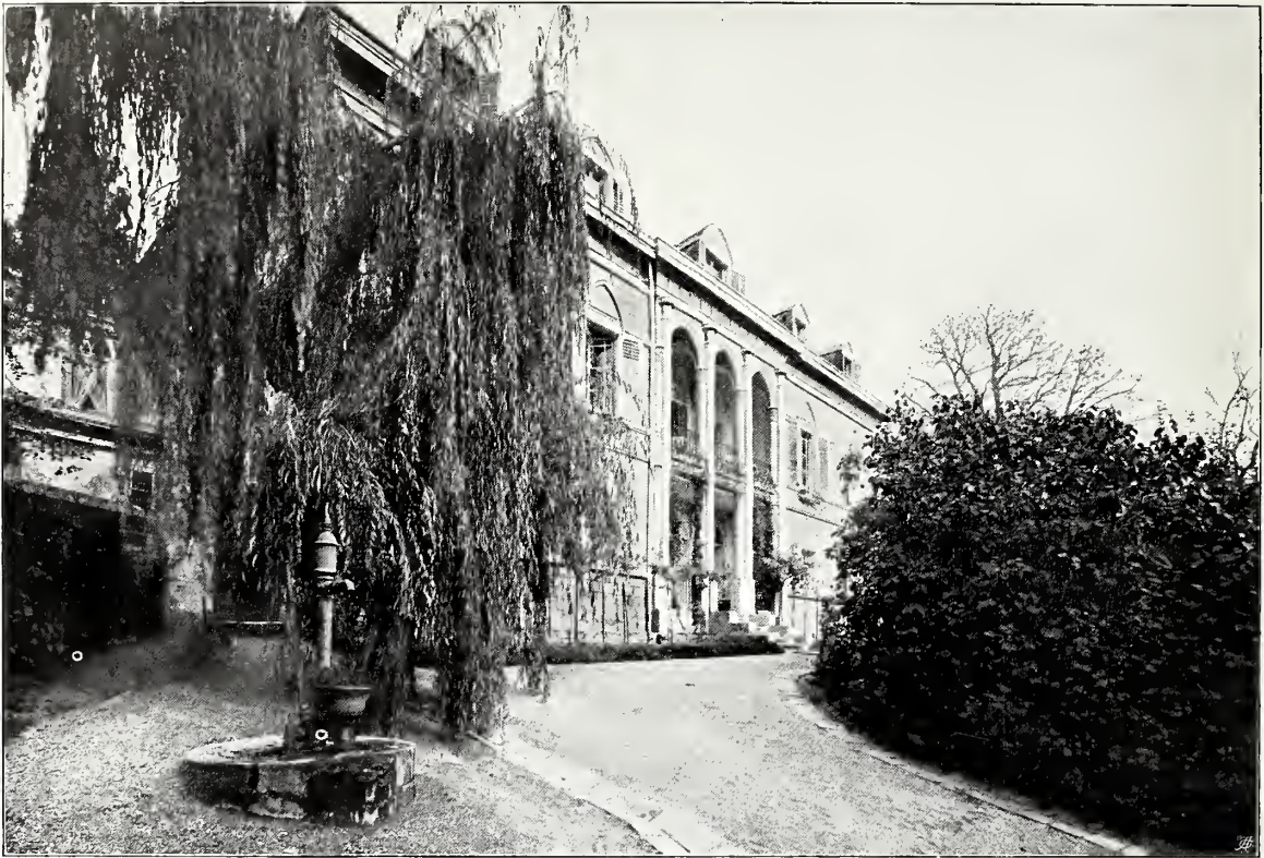
Fig. 353 Pötzleinsdorf, Villa Mautner, Hauptfront (S. 291)
