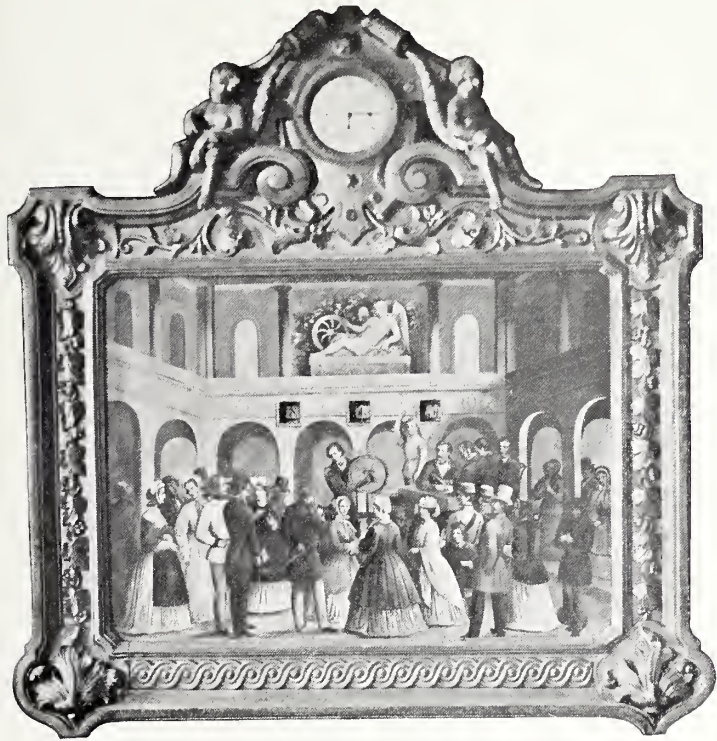
Fig. 592 Sievering, Hauptstraße N. 117, Lotteriezichung (S. 471)
