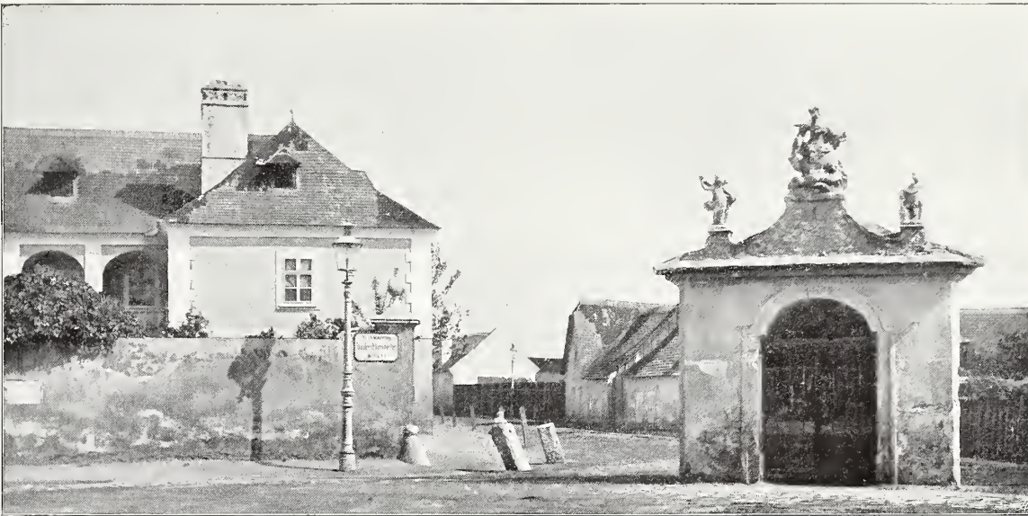
Fig. 3 Kaiser-Ebersdorf, Dreifaltigkeitskapelle und Haus Nr. 290 (S. 5)
