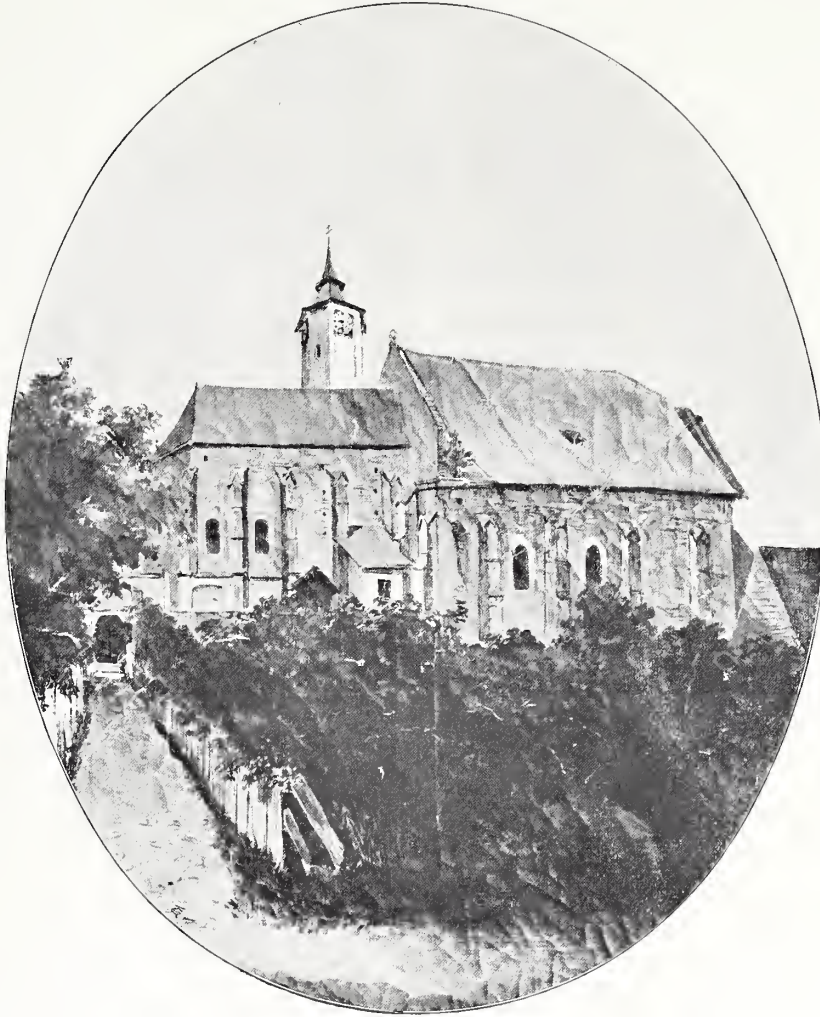
Fig. 507 Heiligenstadt, Michaelskirche vor dem Umbau; nach einem Bilde um 1840 im Besitze des Verfassers (S. 406)
