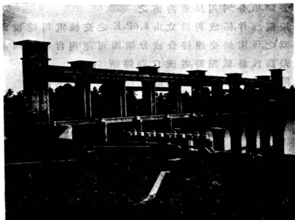
Tjisadane 河活動水閘與西總幹渠進水閘
