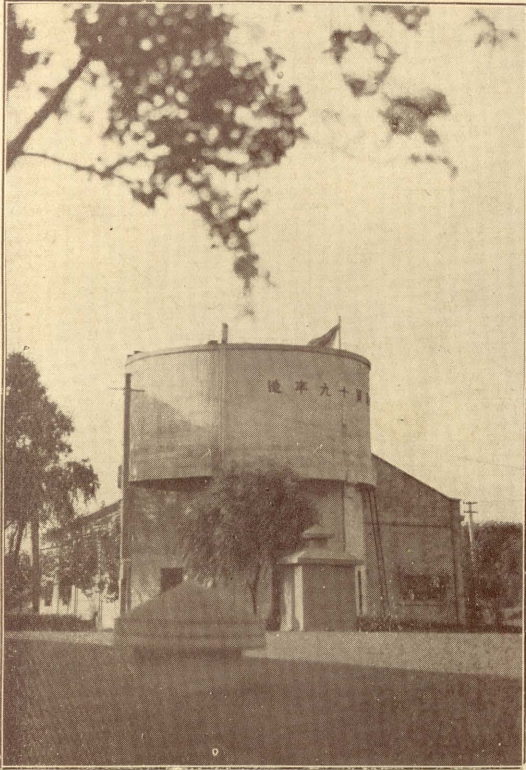
↓ 內地自來水公司洗池水塔
