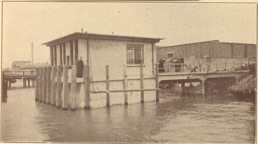
⇒ 浦東水廠混 水進水間
