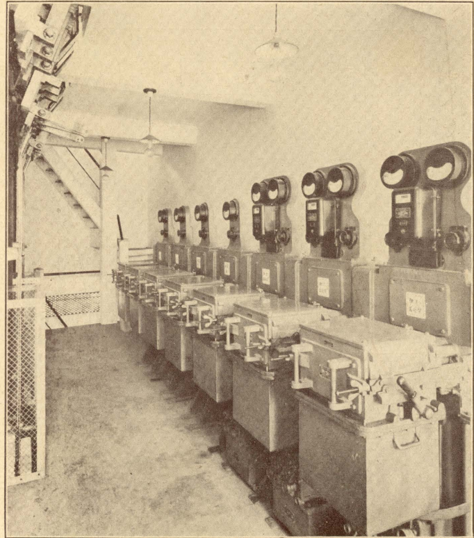
↑ 閘北水電公司淞滬路變壓所 三萬三千伏控電板
