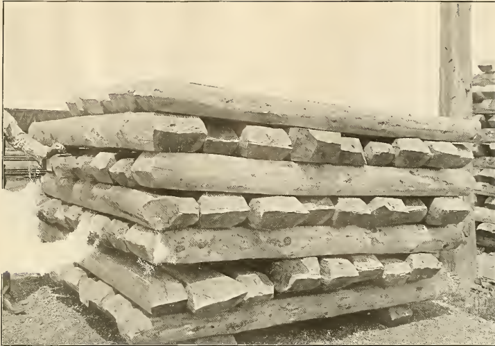
FIG. 1.—LOGGEPOLK PINE—SOLID PILE.
