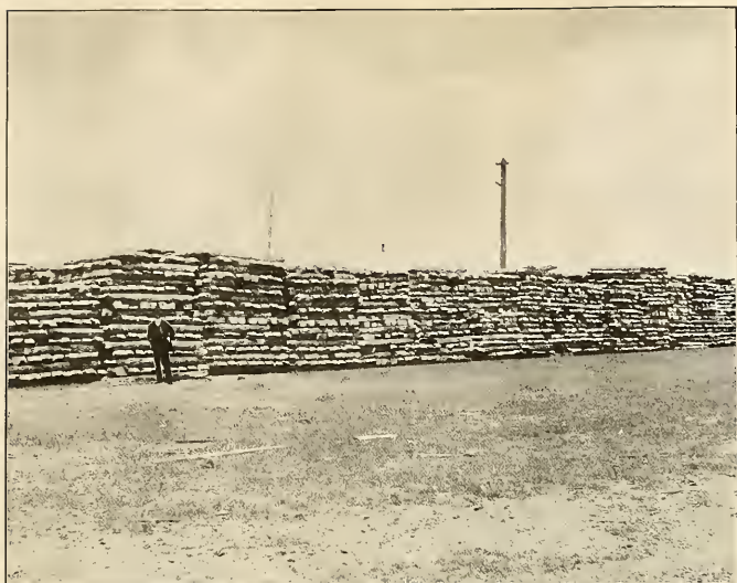
FIG. 1.—TIE YARD, SHERIDAN, WYO., APRIL, 1902—SOLID PILES.
