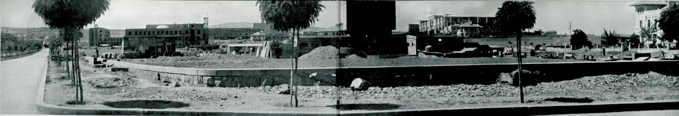
Le nouveau quartier des ministères en construction.
