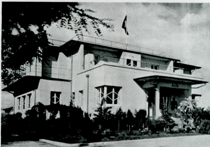
La centrale électrique de l'Institut.
