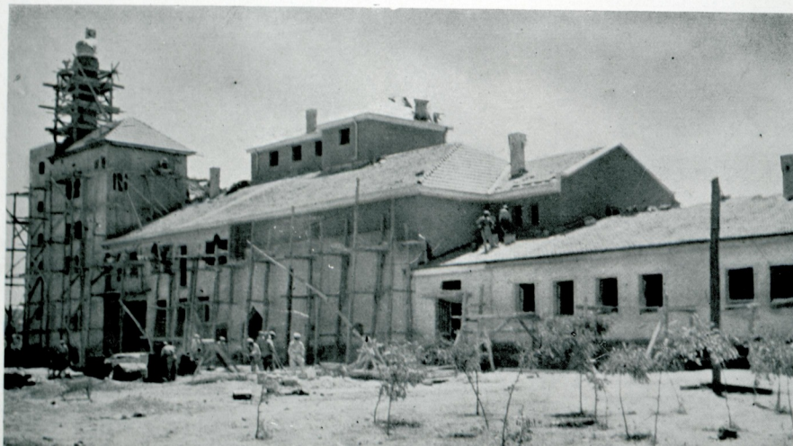
Une brasserie moderne en construction à Ankara.
