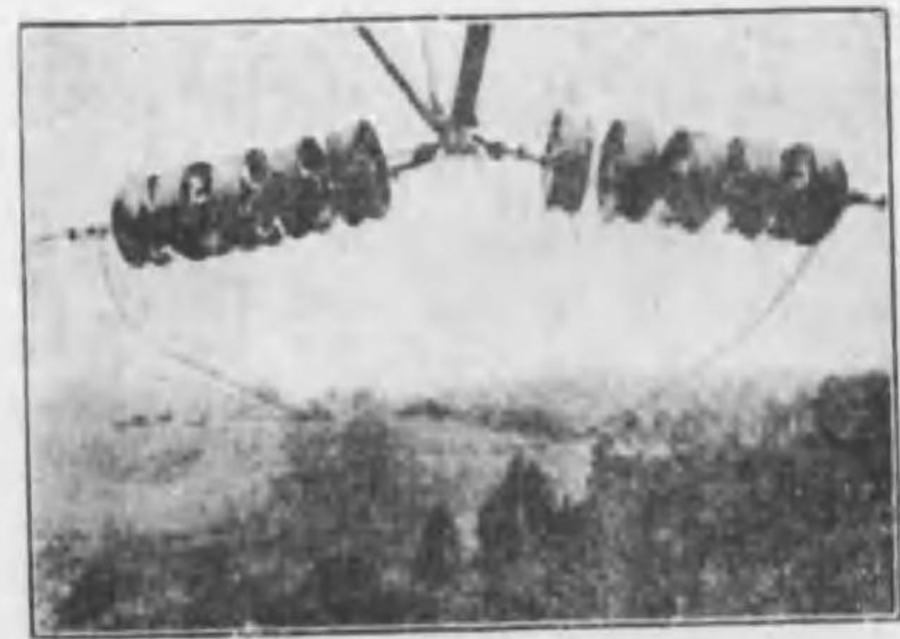
第一二八圖 一萬「ヴォルト」用碍子電線取付
