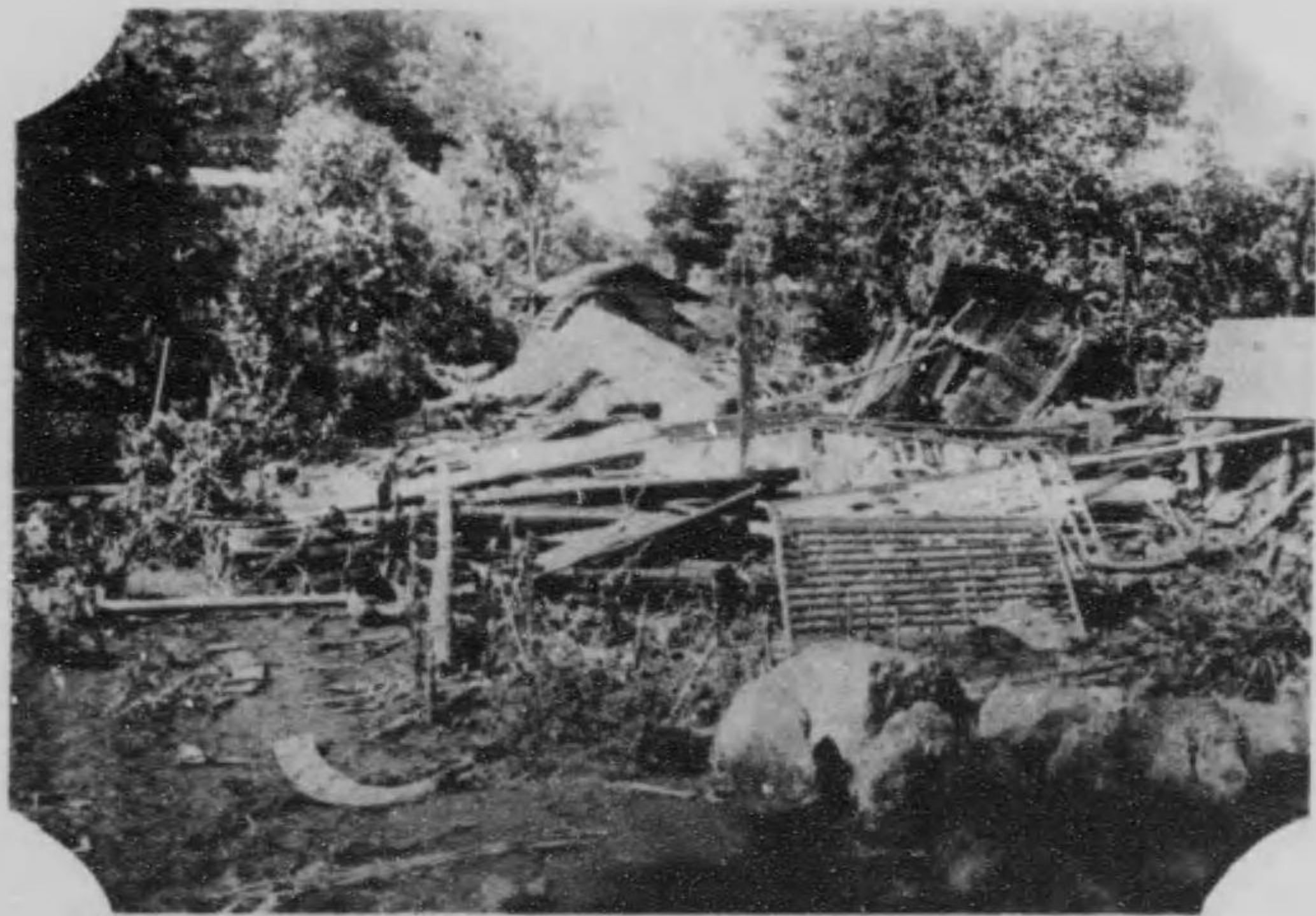
南都留郡明見大村見明家屋倒壊の惨状
