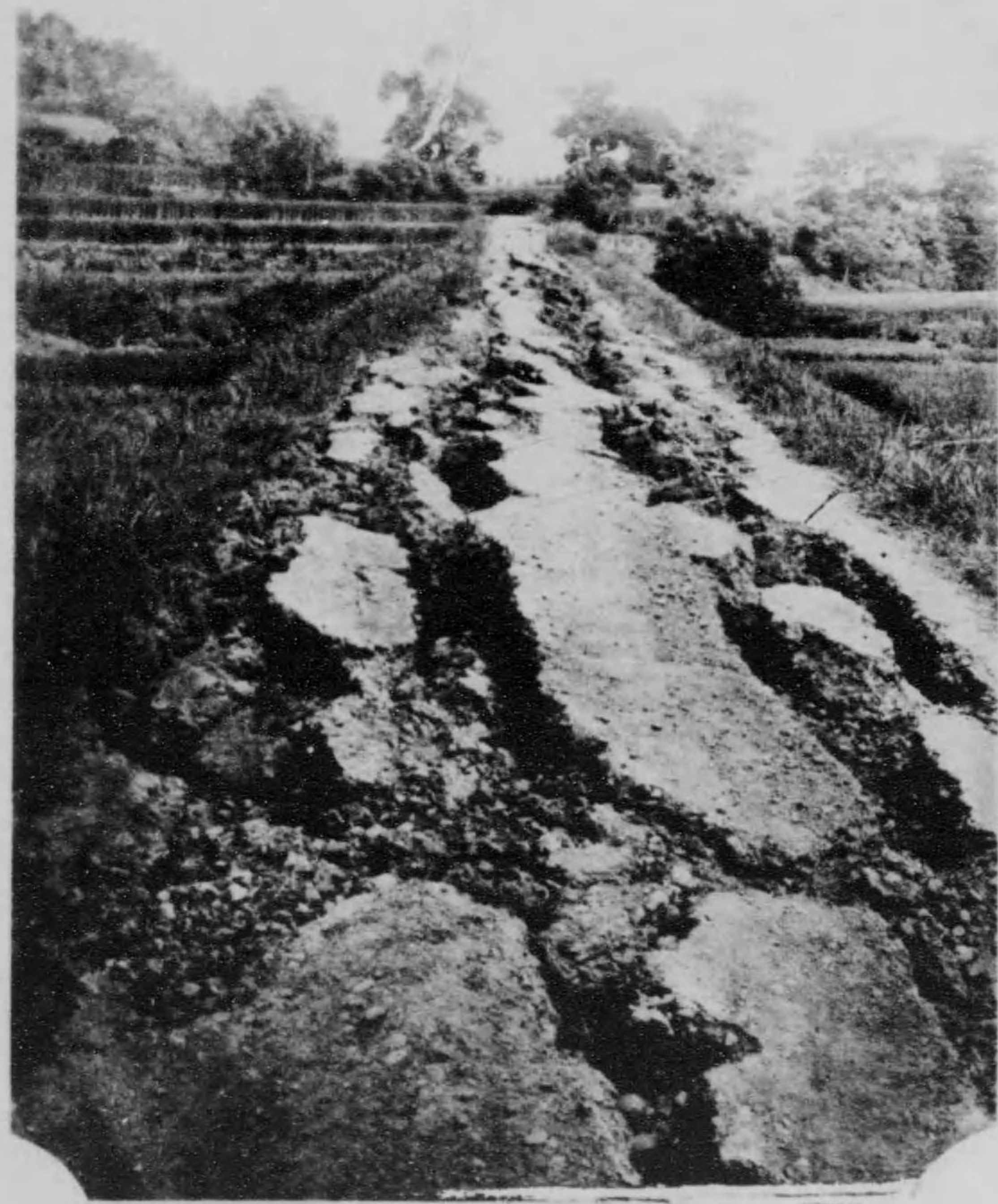
上村賀多線東伊海熱道縣町海熱郡方田 裂龜の路道近附場石白稱俗内地賀多
