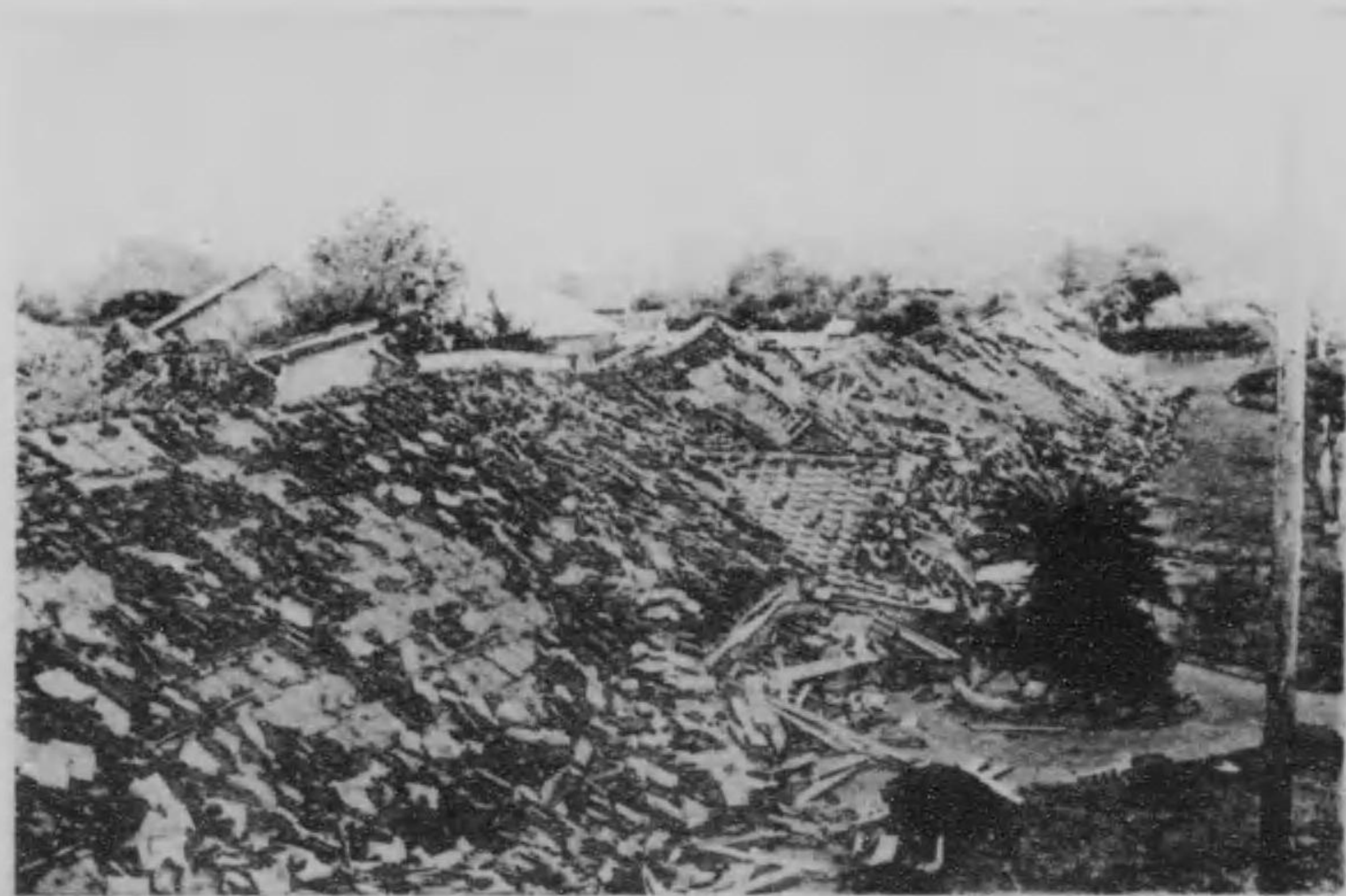
安房高等女学校校舎倒壊の惨状
