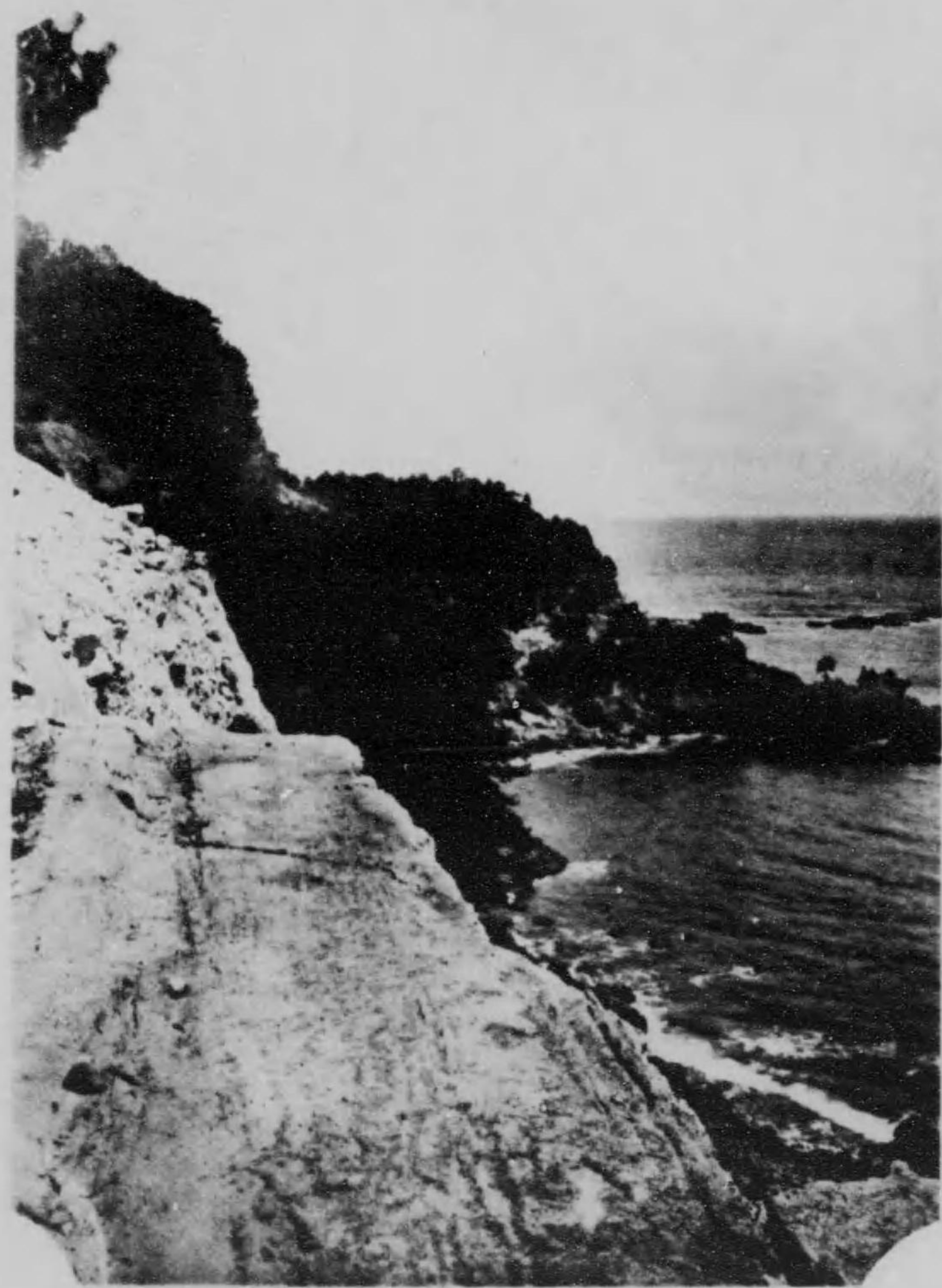
上村賀多線東伊海熱道縣町海熱郡方田 壞崩の路道間根赤・地高稱俗内地賀多
