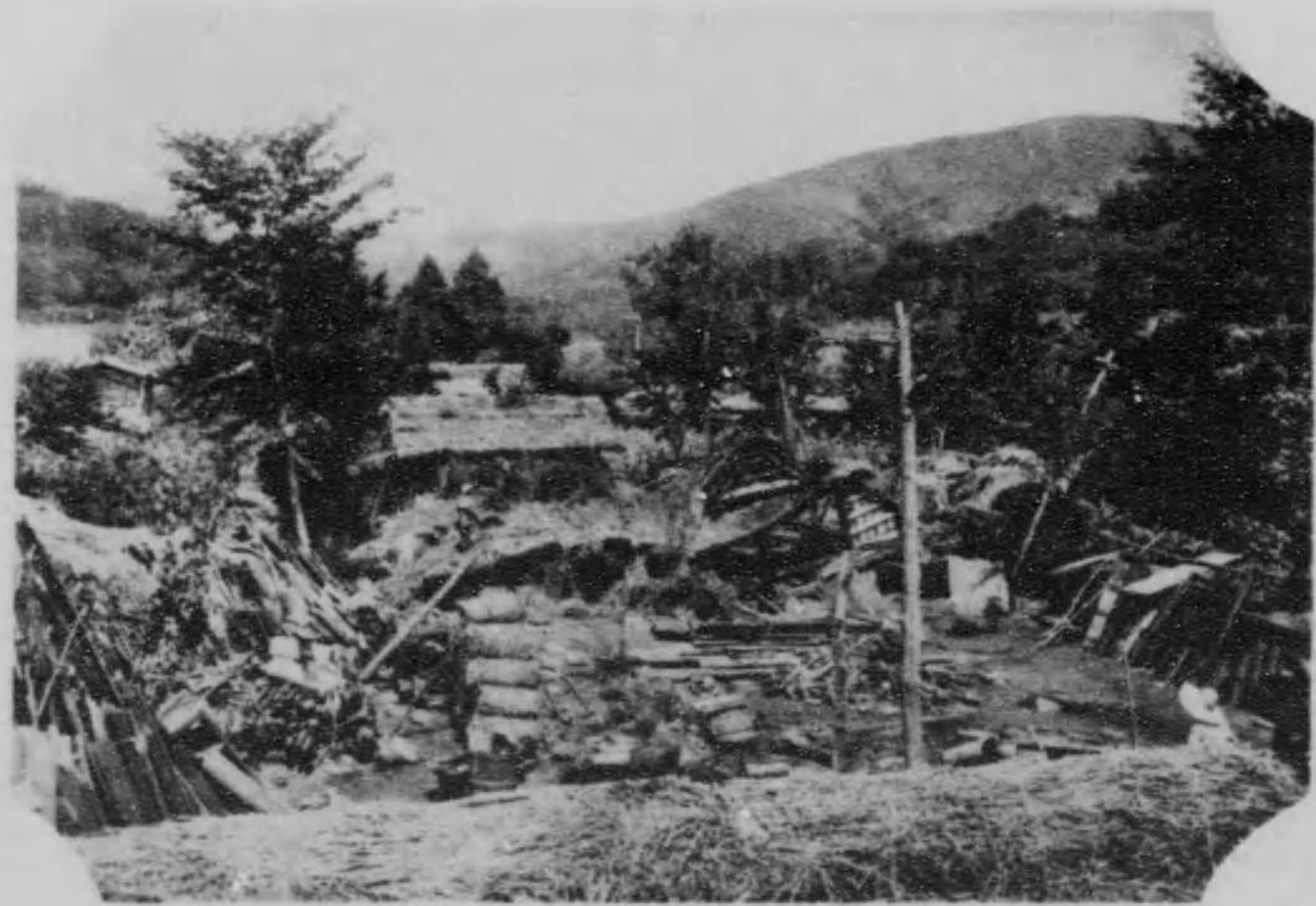
南都留郡中郷長池家屋倒壊の惨状
