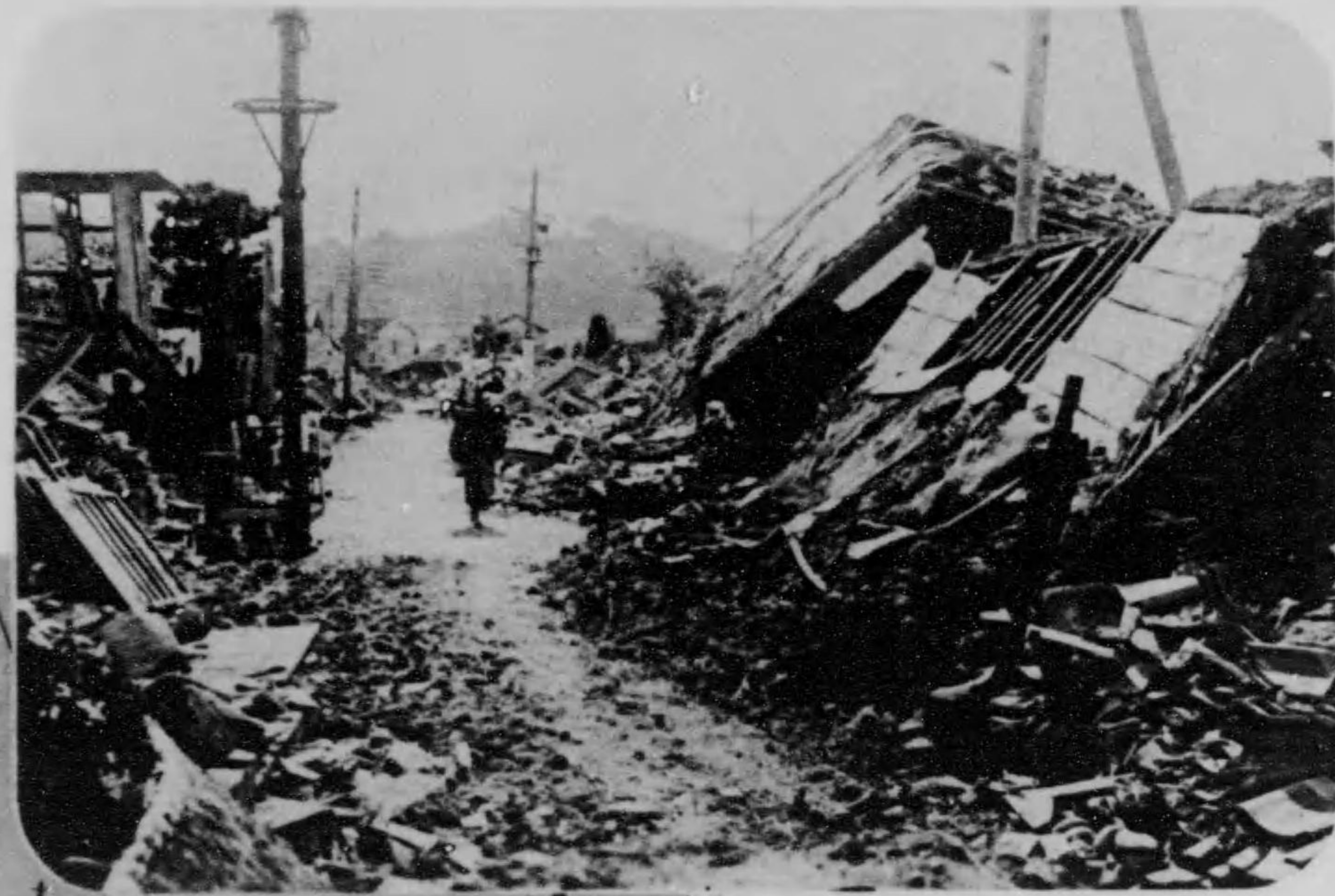
山館町西の潰家屋倒の惨状
