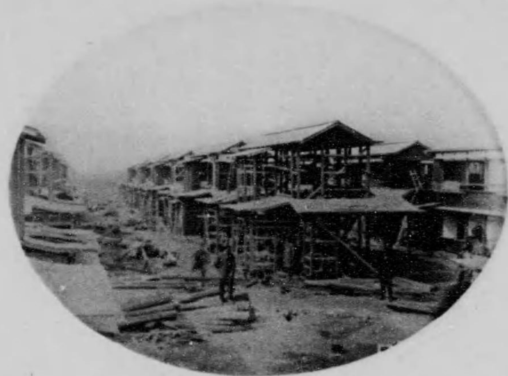
(二共) 況實事工築建宅住一第町砂 (影撮日五月三年四十正大)
