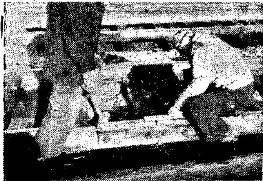
圖十二 校核已補焊好之軌頂
