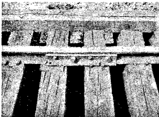
圖二 內外相錯螺栓 注意左側之道釘應予拔出重打
