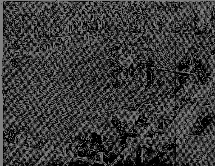
↑ 在分洪區計劃修建三個大水閘：過洪閘、節制閘、攔洪閘。這是工人在過洪閘工地上研究怎樣使閘墩修得更堅固。 新华社稿
