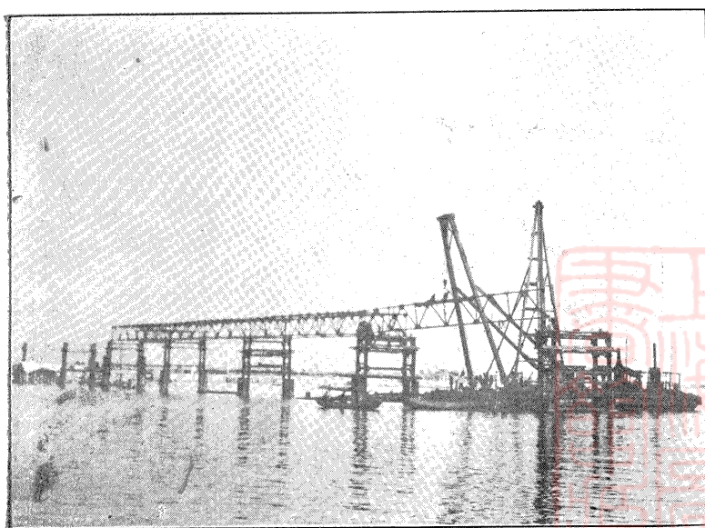
安裝桁梁之情形(第十八圖)
