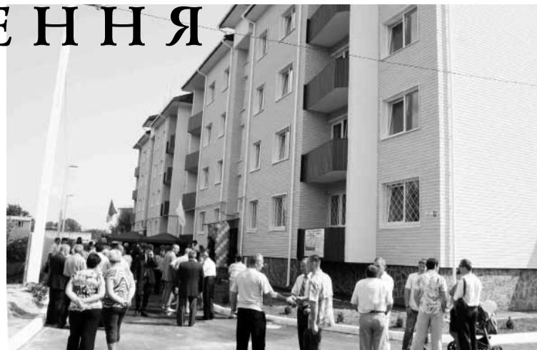
Окрасою Макарова став 40-квартирний будинок, зведений для спеціалістів підстанції 750 кВ «Київська» у 2011 році.
