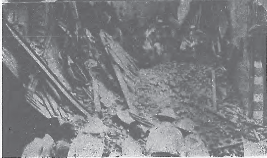
↑ 避難之居民。 ← 俾爾麥大地震之慘狀， 圖示居屋崩坍，遭難者三下 四名被起出時情形。
