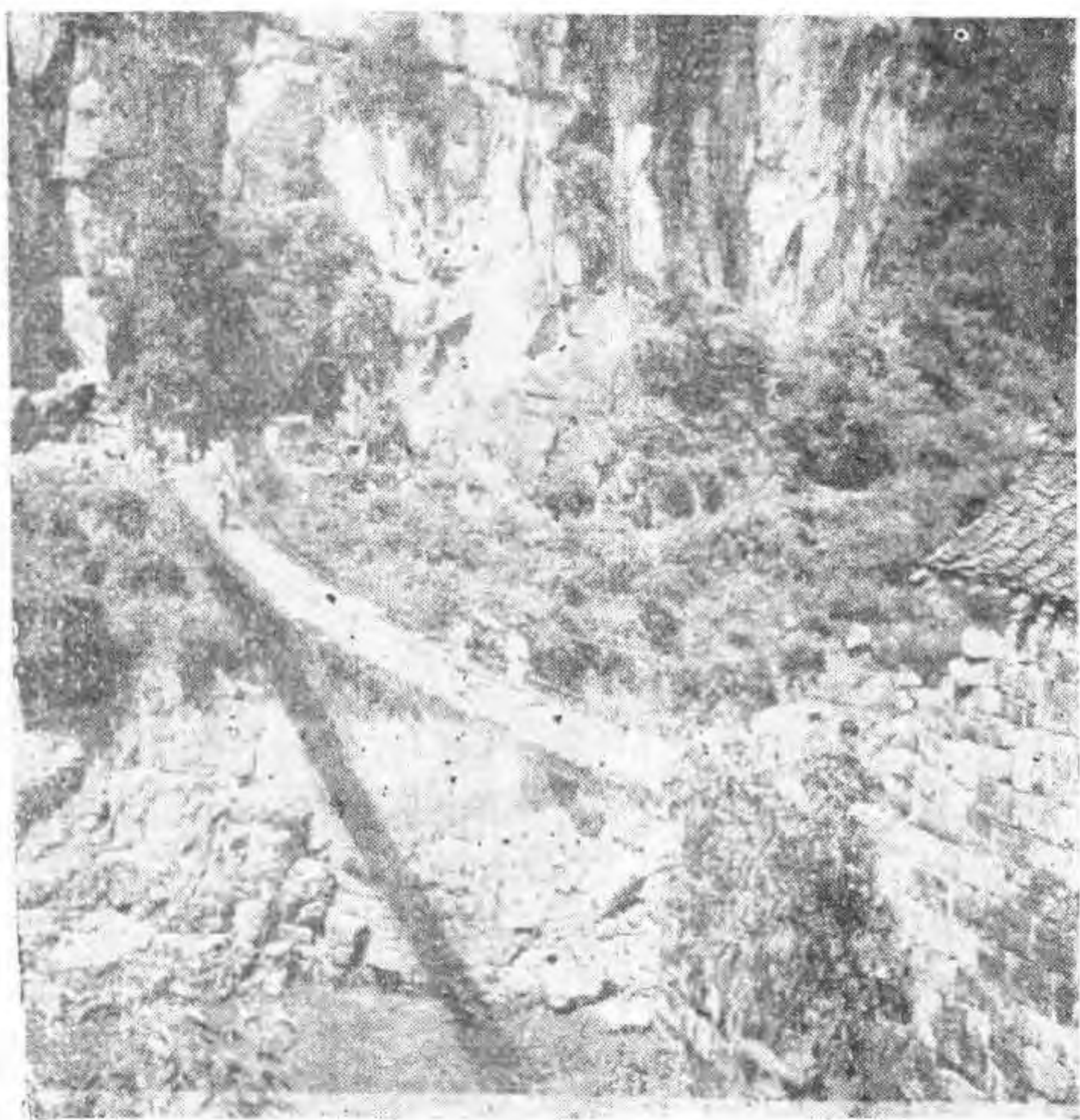
花江坡鐵鍊橋
