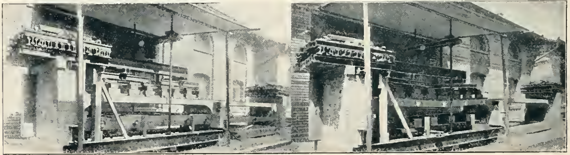
Abb. 20. Deckenprüfung (nach Martens und Guth, Denkschrift).
