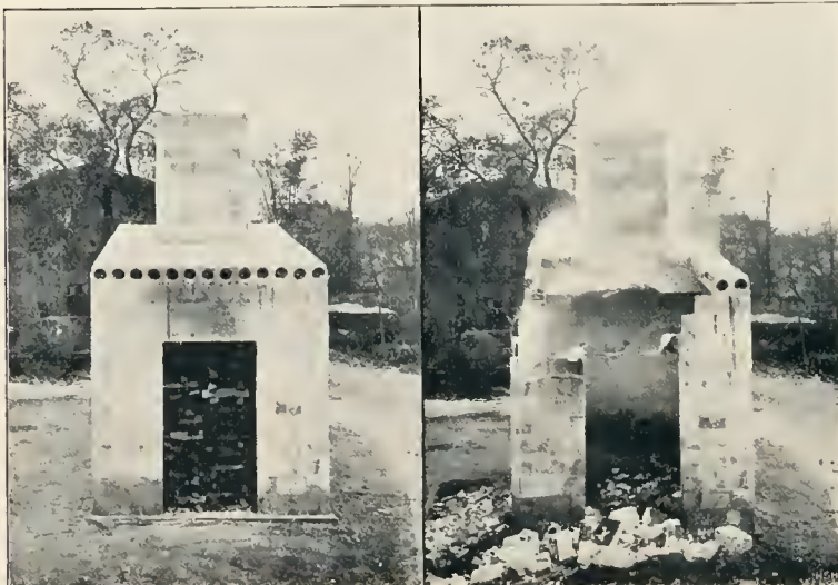
Abb. 21. Brandversuch (nach Martens und Guth, Denkschrift).
