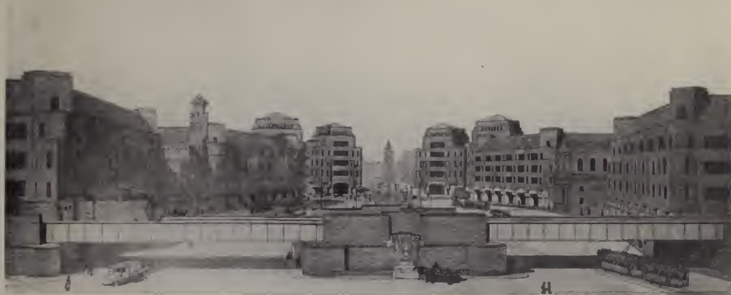
GEZICHT VAN HET HOOG KANTOORGEBOUW OVER HET PLEIN NAAR HET VEREENIGINGS- PUNT VAN COOLSINGEL, KRUISKADE, DIERGAARDELAAN EN STATIONSWEG. LINKS DE TOE- GANG TOT HET HAAGSCHEVEER, RECHTS DE DELFTSCHEPOORT.
