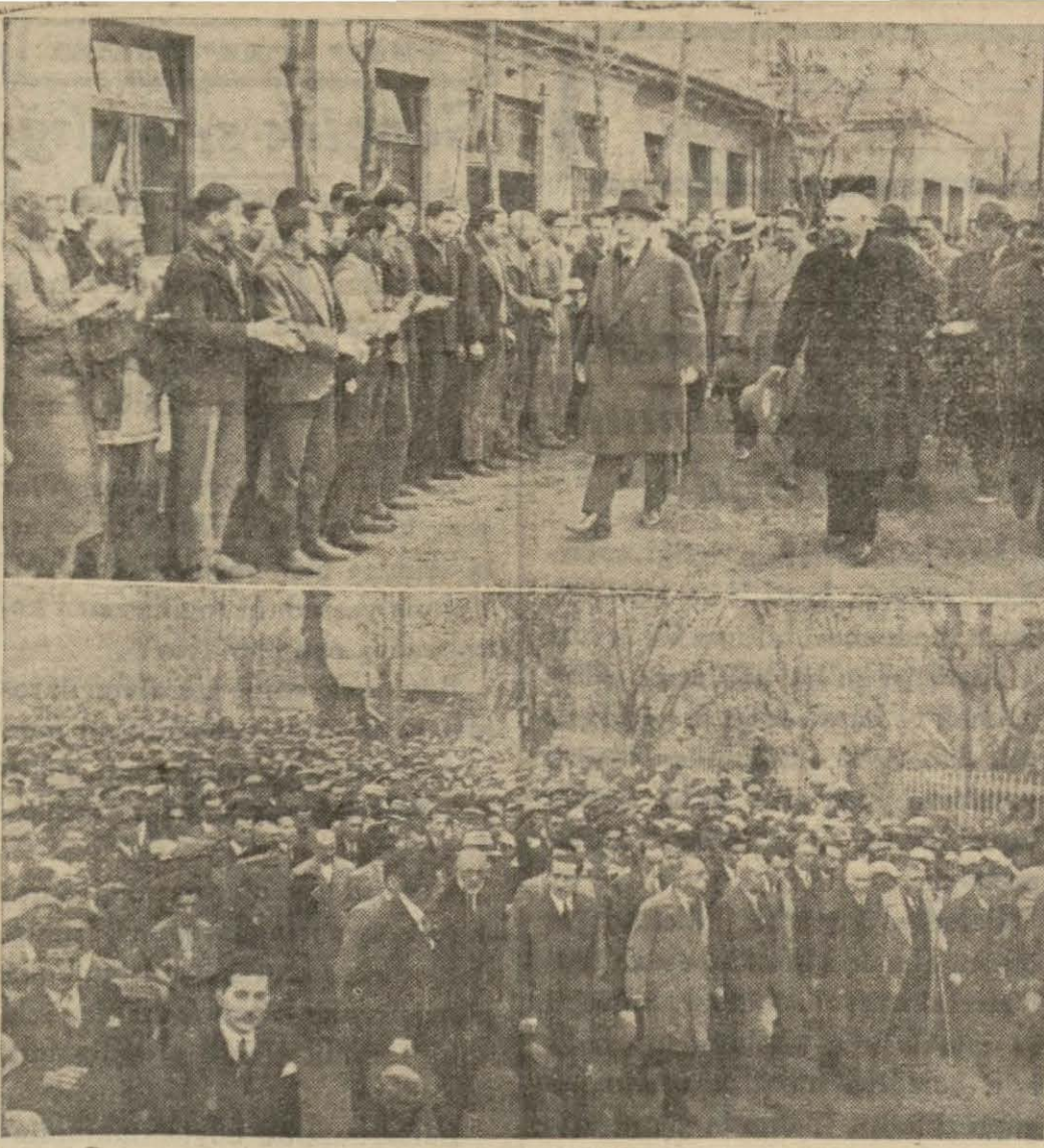
Başvekil İsmet paşanın son seyahatine ait iki resim: Yukarıda Eskişehir demiryollar fabrikasını gezerken, aşağıda Ereğlide dokuma fabrikasının temel atma resmini yapmağa giderken.
